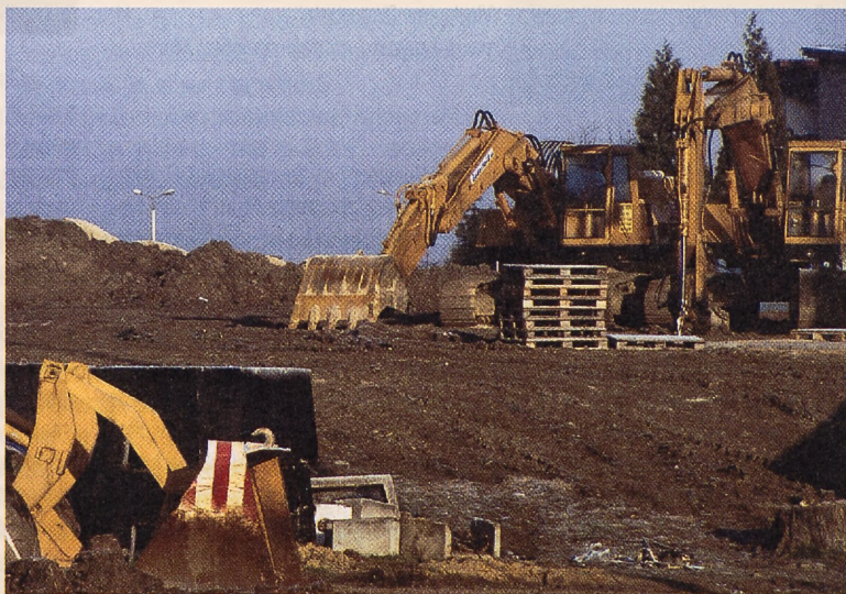
Ciężki sprzęt pracuje na przebudowywanym skrzyżowaniu Hulanka.
