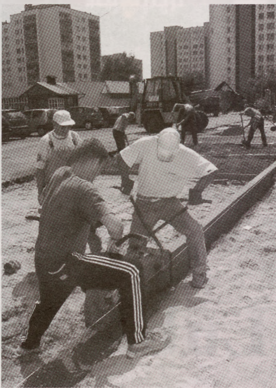
Trwa remont chodnika przy ulicy Marusarzówny oraz budowa miejsc parkingowych.
