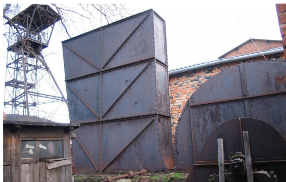
53. Wentylator przy szybie „Cecylia”, stan obecny.
