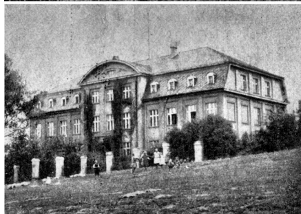
26. Budynek dyrekcji, przed i po rozbudowie.
