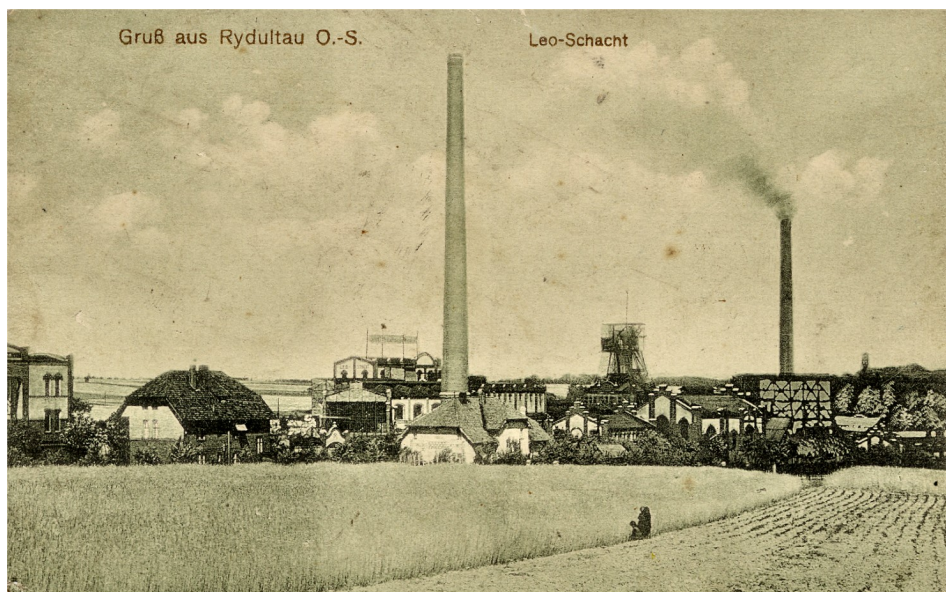
43. Nowa kotłownia przy szybie „Leo”.
