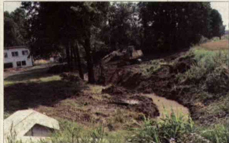
Prace przy Lubrzance
