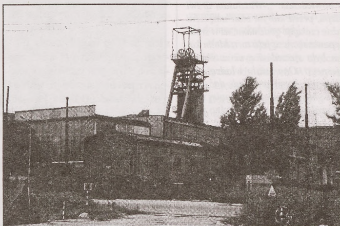
Ruch II kopalni „Saturn” w Milowicach.
