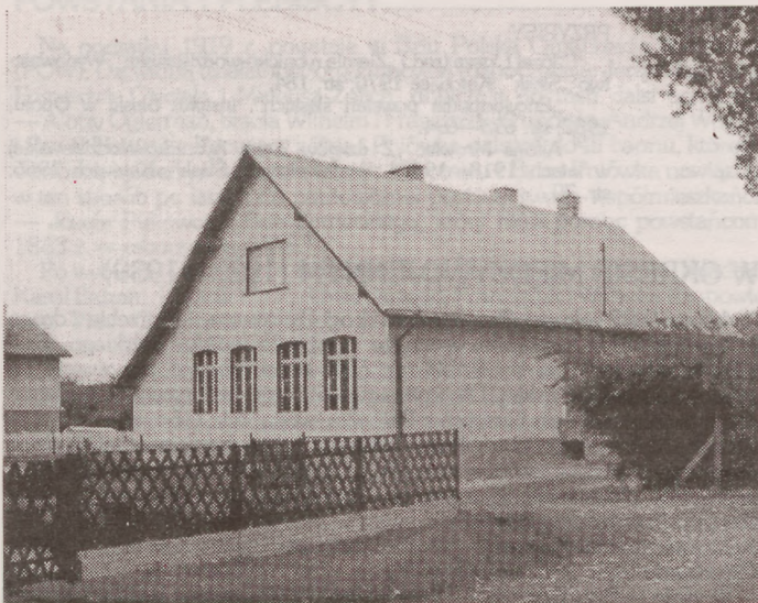
Budynek dawnej szkoły ewangelickiej z 1889 r. w Bziu Górnym. Obecnie stanowi część składową Szkoły Podstawowej.
