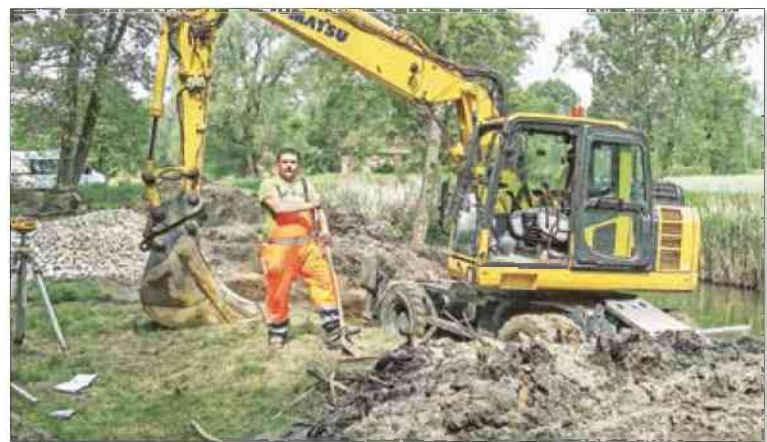
W ubiegłym tygodniu budowana była studnia przy rzece
