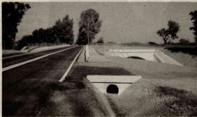
Nowy most w Bernacicach Górnych już służy użytkownikom drogi
