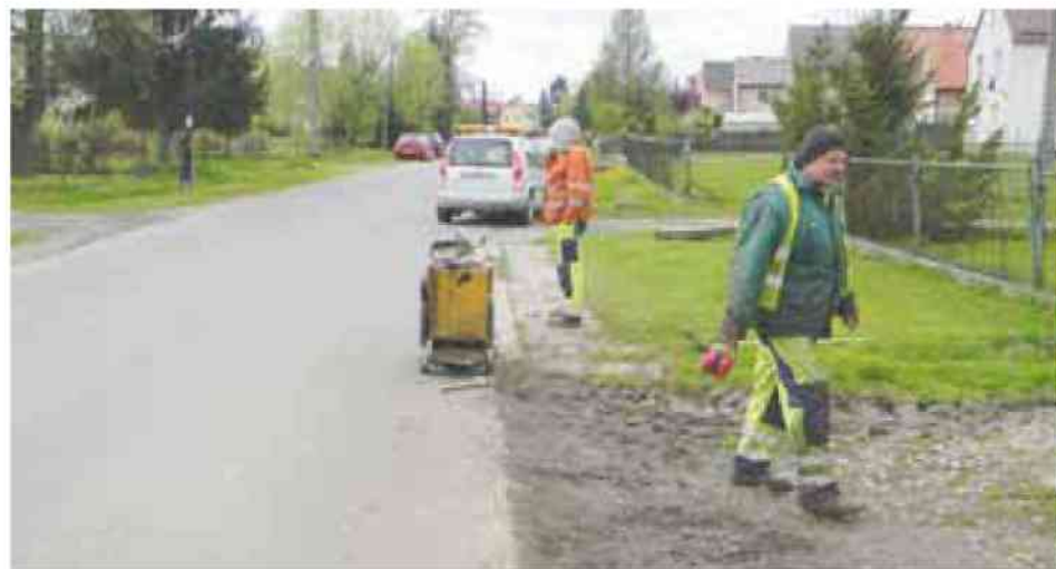
W Złotogłowicach rusza kolejny etap budowy chodnika
