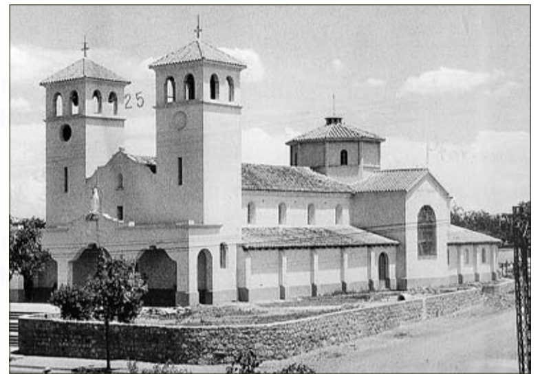
Neubau der Kirche Santa Teresita (1954 – 1957)
