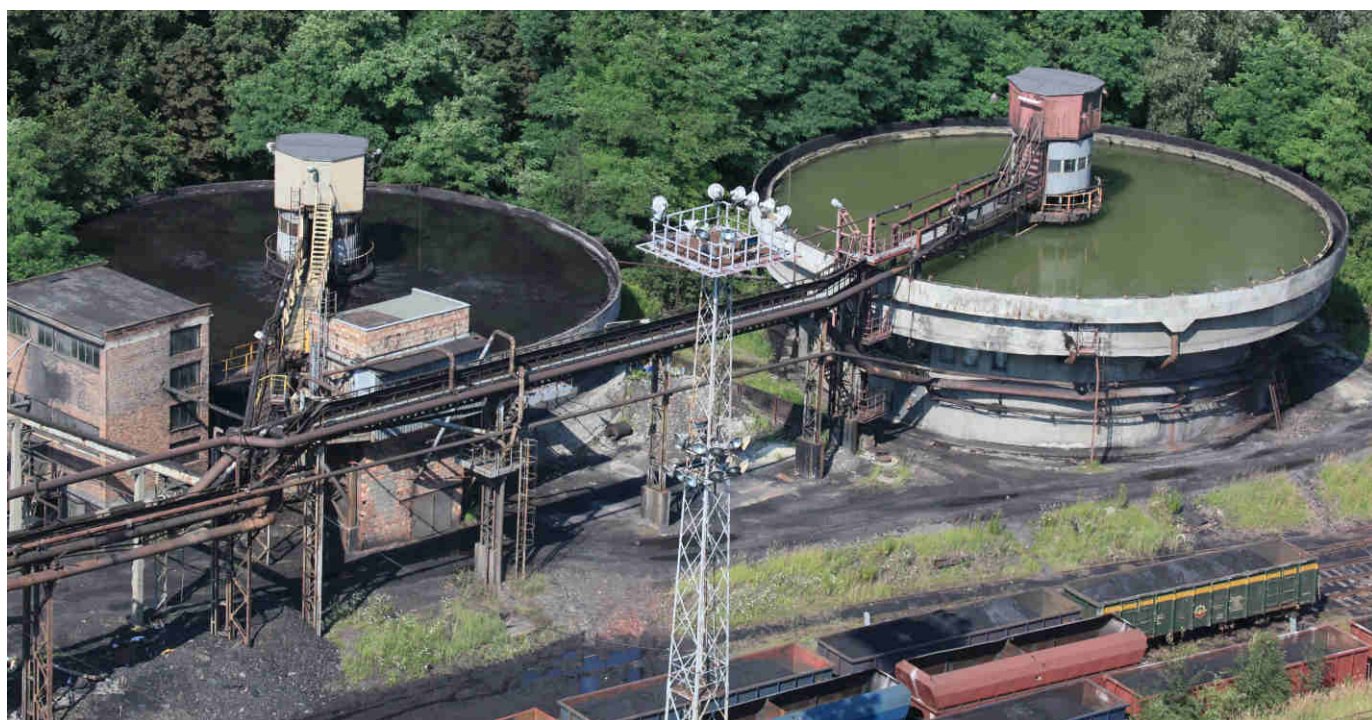
Osadniki Dorra zakładu przeróbczego.
