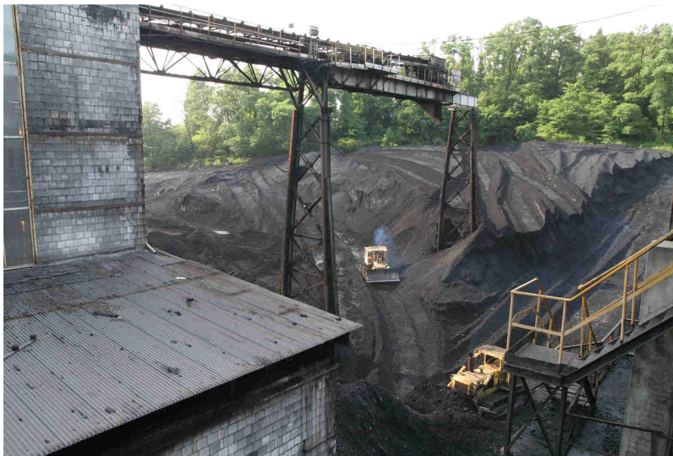
Taśmociąg z płuczki na zwalę węgla.
