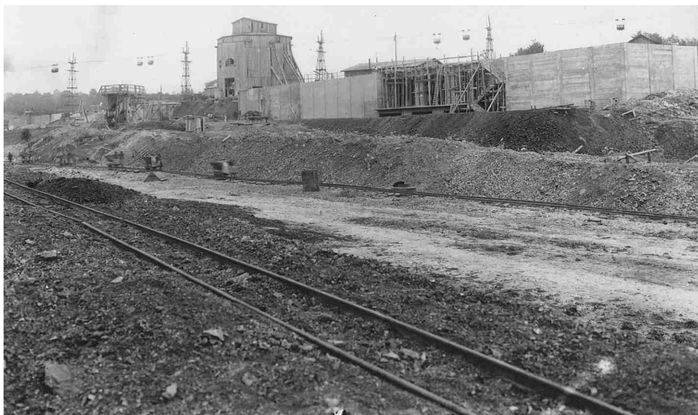
Budowa szybu Rudolf (późniejszy Chrobry I), wrzesień 1915 rok.
