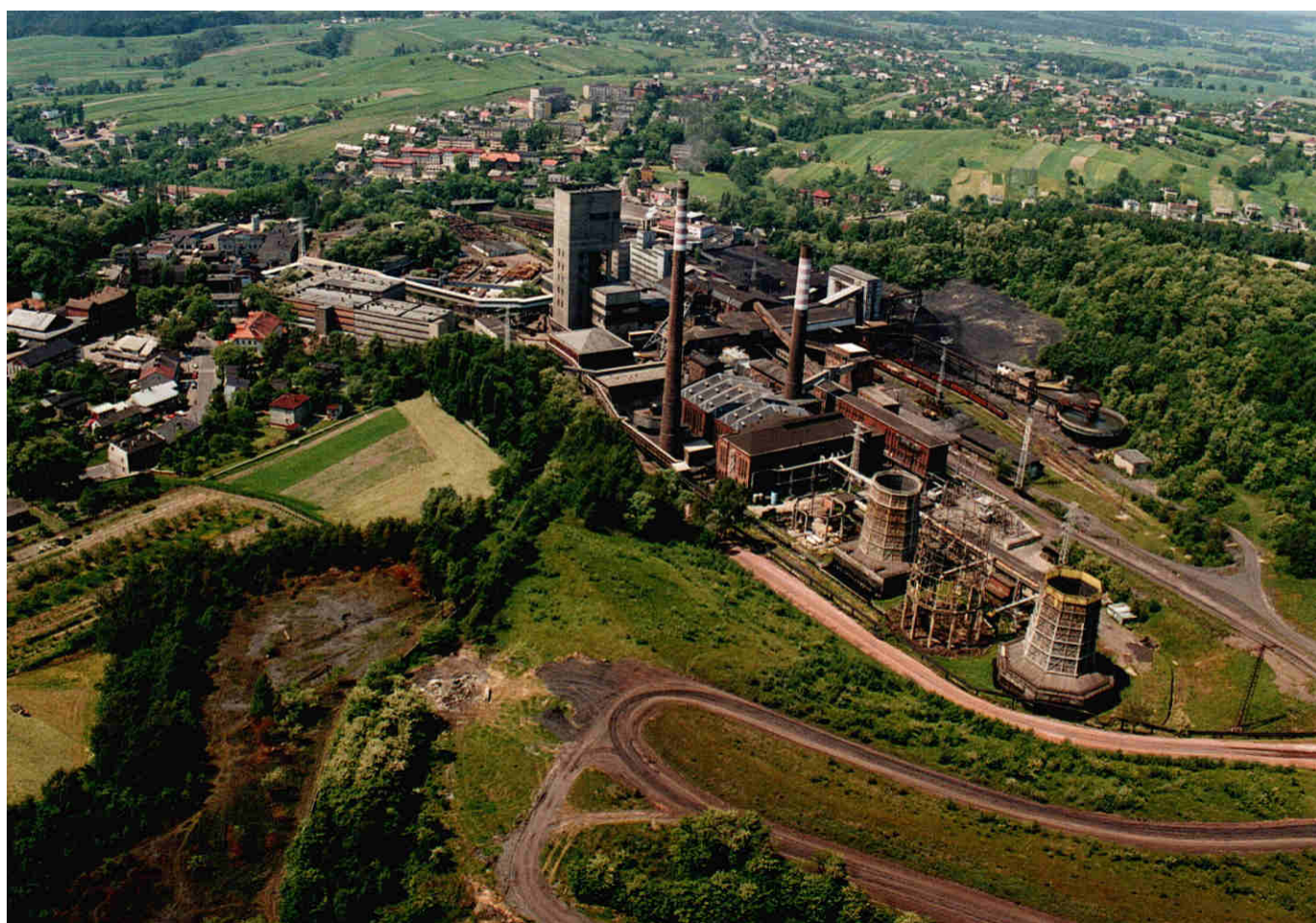
Widok z lotu ptaka na uporządkowany teren dawnych zwałowisk kamienia wokół elektrociepłowni.
