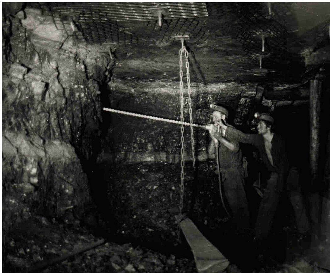
Od 1974 roku zaczęto stosować coraz częściej obudowę kotwiczną. Początkowo jako samodzielną, a później jako wzmocnienie wyrobisk w obudowie ŁP.
