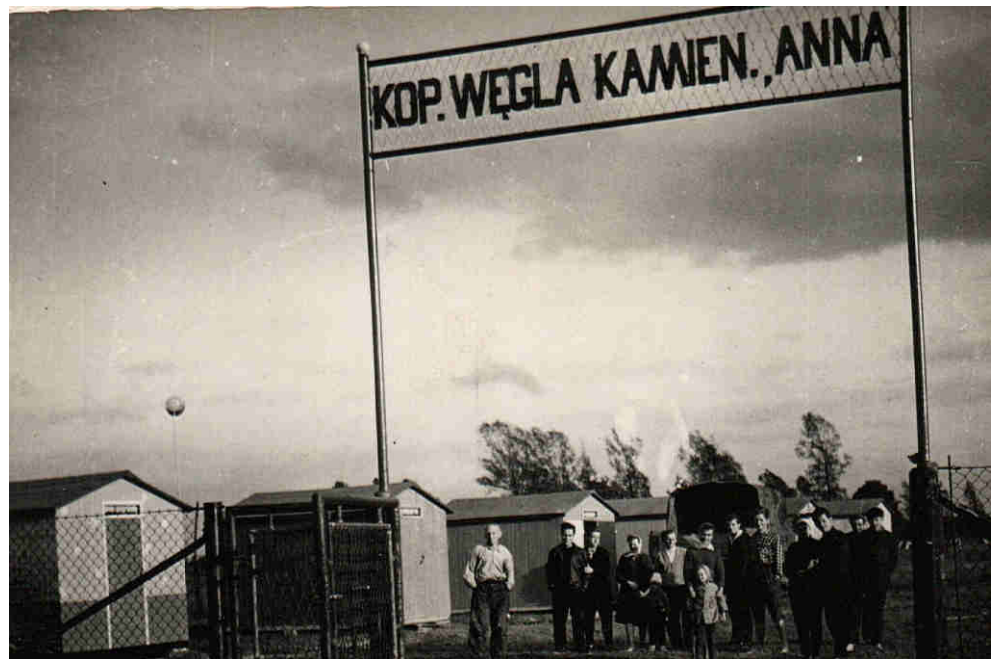
Budowę ośrodka wypoczynkowego kopalni Anna w Dźwirzynie rozpoczęto w 1962 roku.
