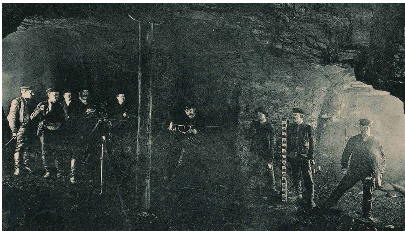
Miernik dokonuje pomiaru kierunku dla zabierki z dowieżchni, 1934 rok.
