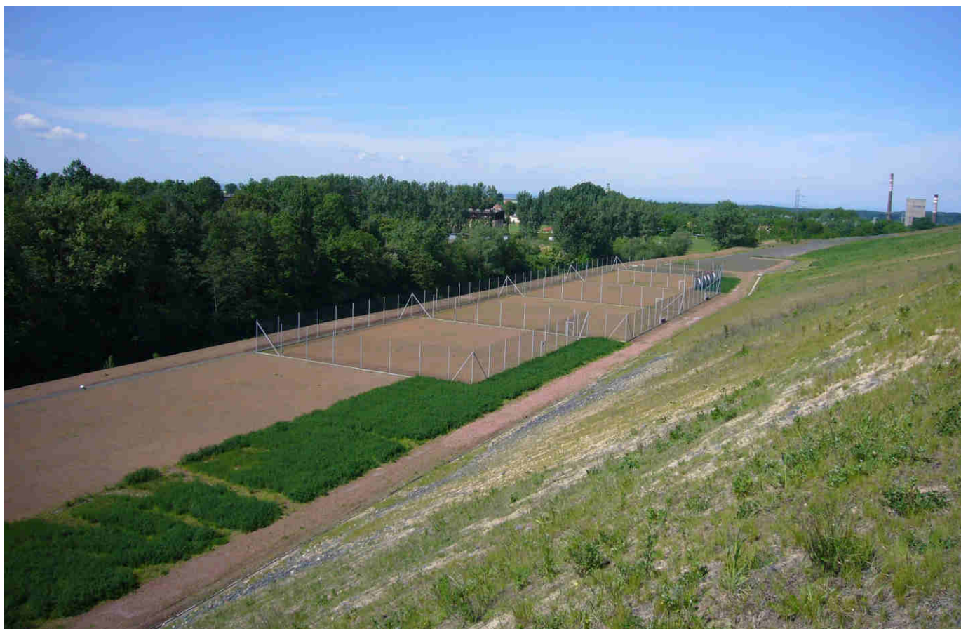
U podnóża zwałowiska wybudowano ciąg kortów tenisowych dla mieszkańców Pszowa.
