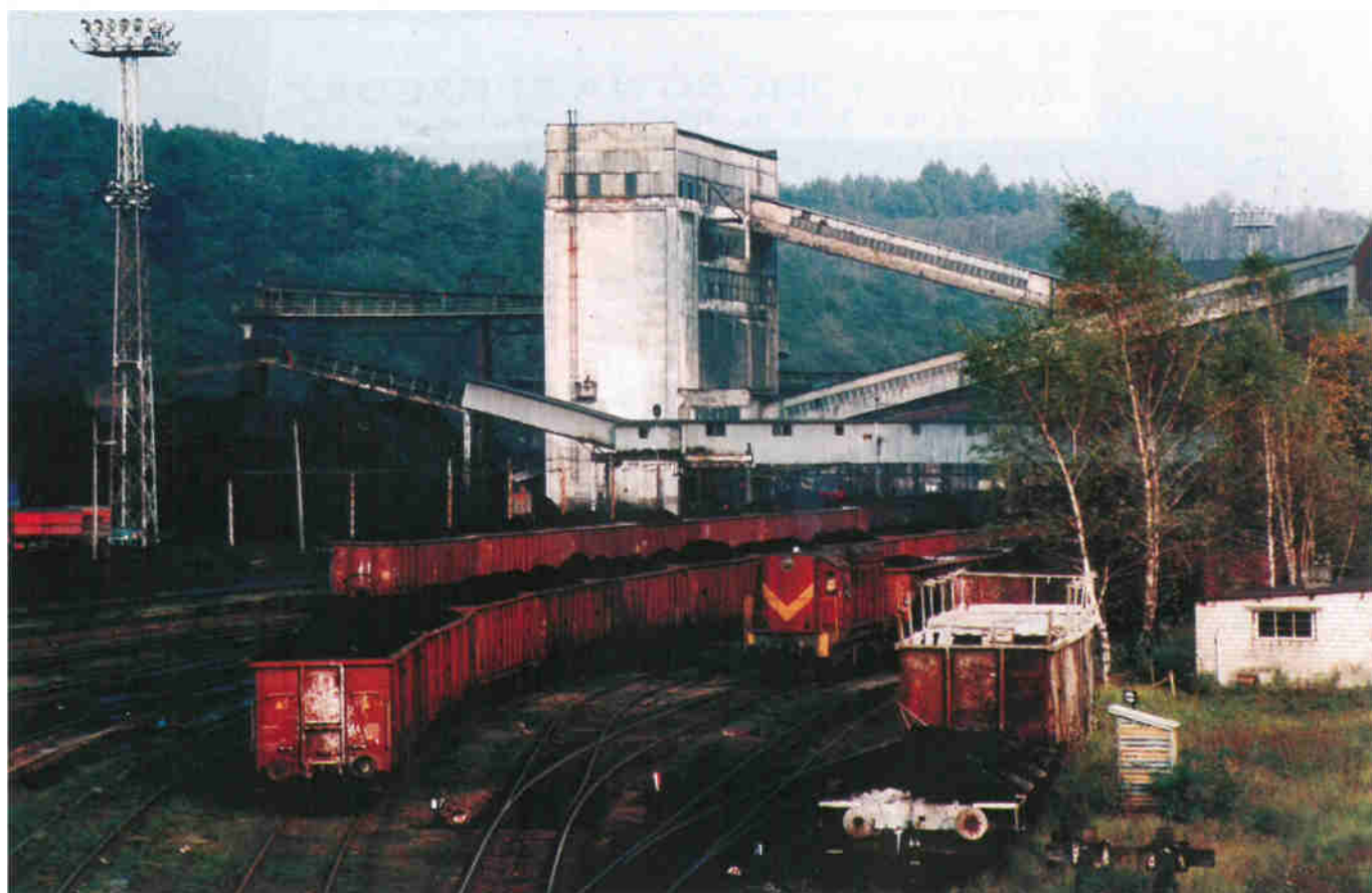
Łącznica kolejowa, z tyłu budynek sortowni i płuczki.
