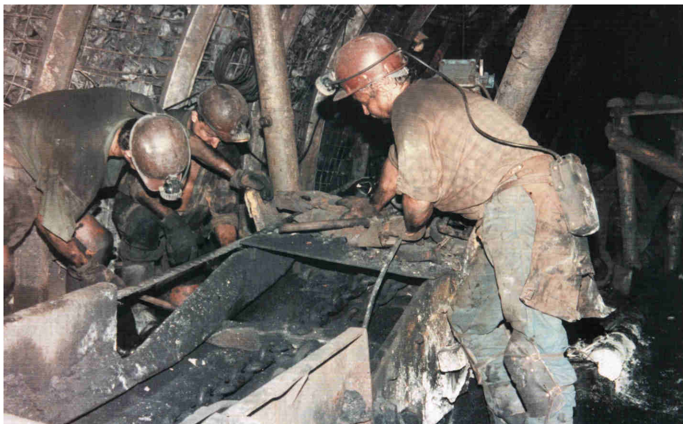
Przebudowa stacji zwrotnej grotła.
