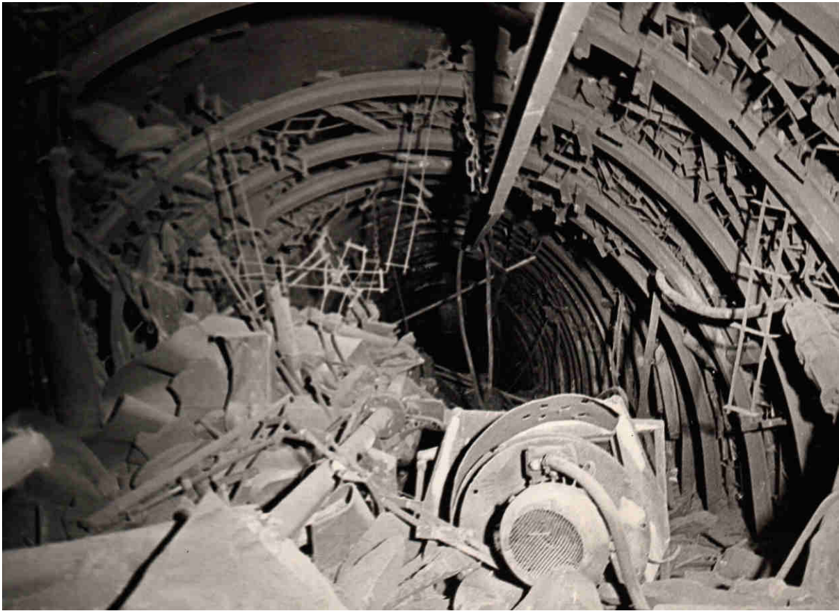
Pokład 630 poziom 700 m stan po tąpnięciu, wybuchu metanu i pyłu węglowego.
