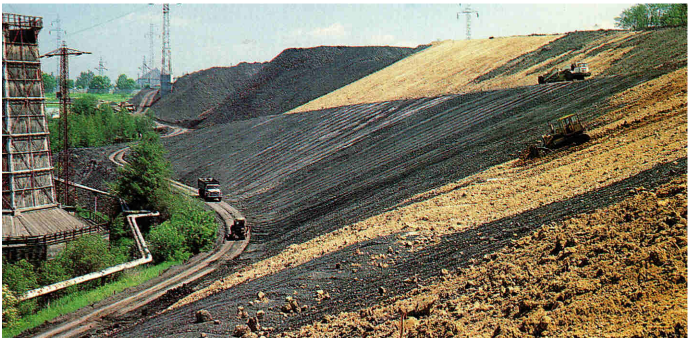
Prace rekultywacyjne za Elektrociepłownią na dawnych zwalowiskach kamienia. Pokrywanie terenu warstwą ziemi.
