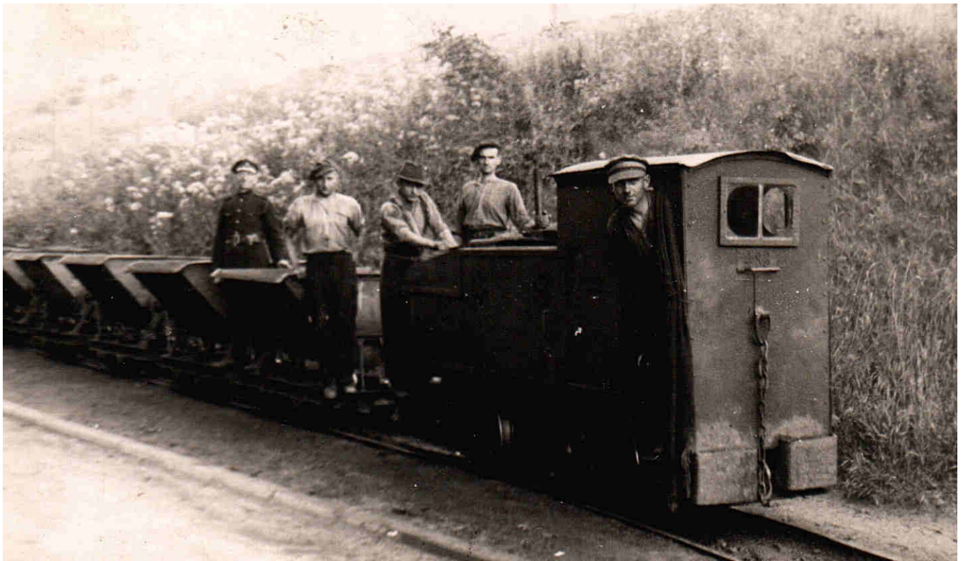
Wjazd kolejki wąskotorowej na haldę. Lokomotywa ciągnęła wagoniki zwane popularnie „Kolybami”, sierpień 1938 roku.
