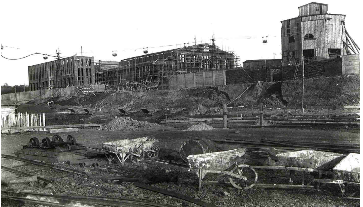
Intensywna rozbudowa kopalni, 1918 rok. Budowa magazynu głównego.
