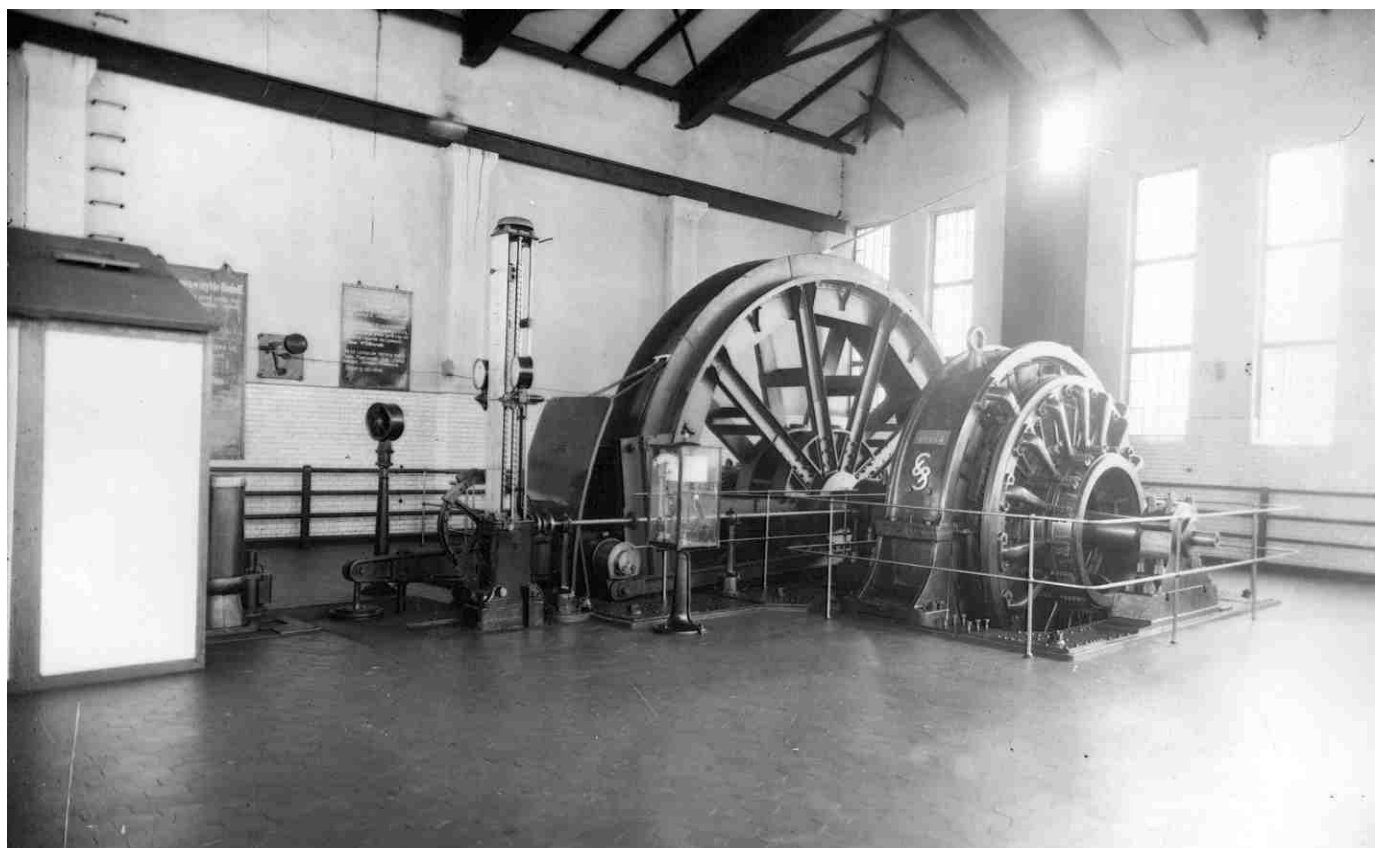
Maszyna wyciągowa zainstalowana na szybie Rudolf, około 1917 roku.
