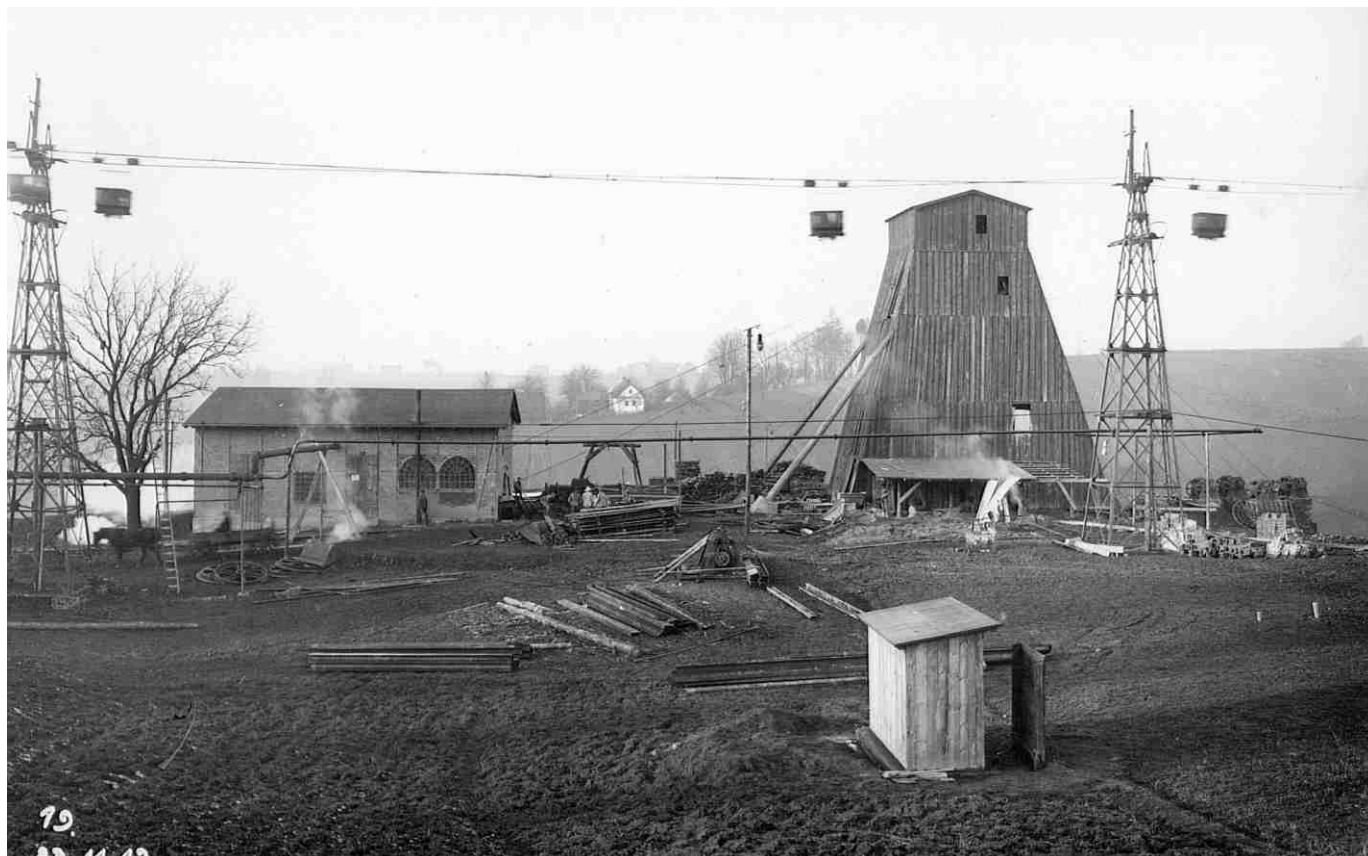
Szyb Rudolf podczas głębnienia do poziomu 260 m. Zdjęcie wykonane w listopadzie 1912 roku.
