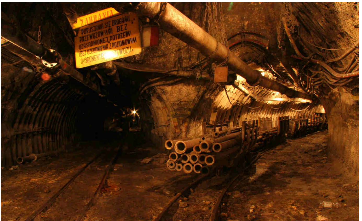
Przekop łączący poziom 1000 m.
