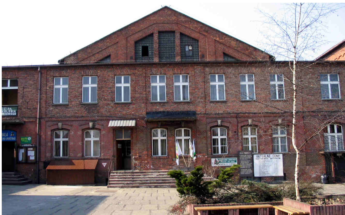
W 1911 roku oddano do użytku łaźnię urzędniczą. Z tyłu hala sportowa, a obecnie pomieszczenia działu szkoleniowego i BHP.
