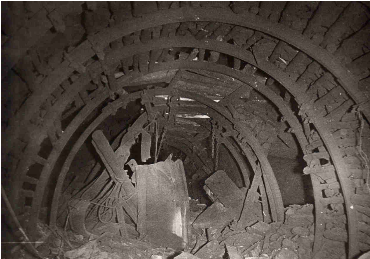
Pokład 630 poziom 700 m stan po tąpnięciu, wybuchu metanu i pyłu węglowego.
