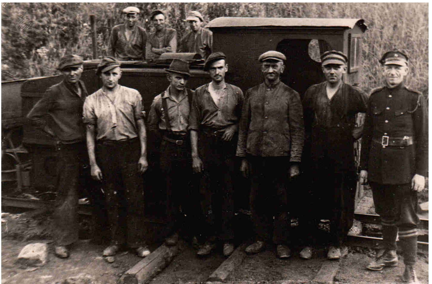
Pracownicy powierzchni przy lokomotywie spalinowej wąskotorowej, sierpień 1938 roku.
