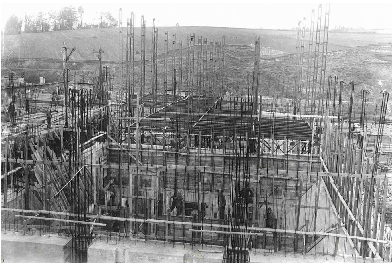
Budowa zakładu przeróbki mechanicznej, październik 1916 roku.
