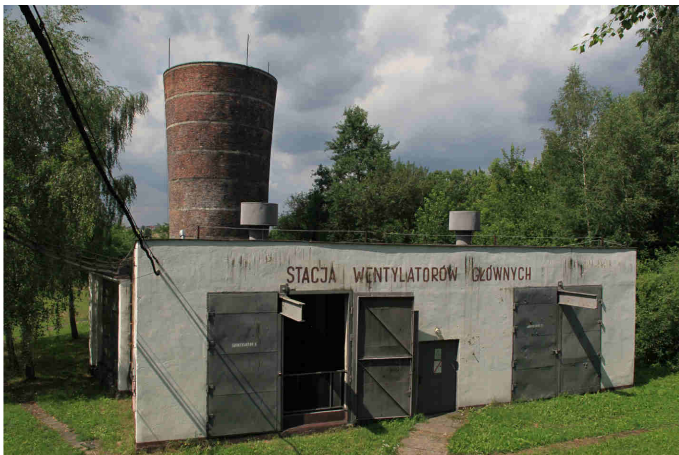
Budynek wentylatorów głównych szybu Ryszard. Zdjęcie z lipca 2010 roku.
