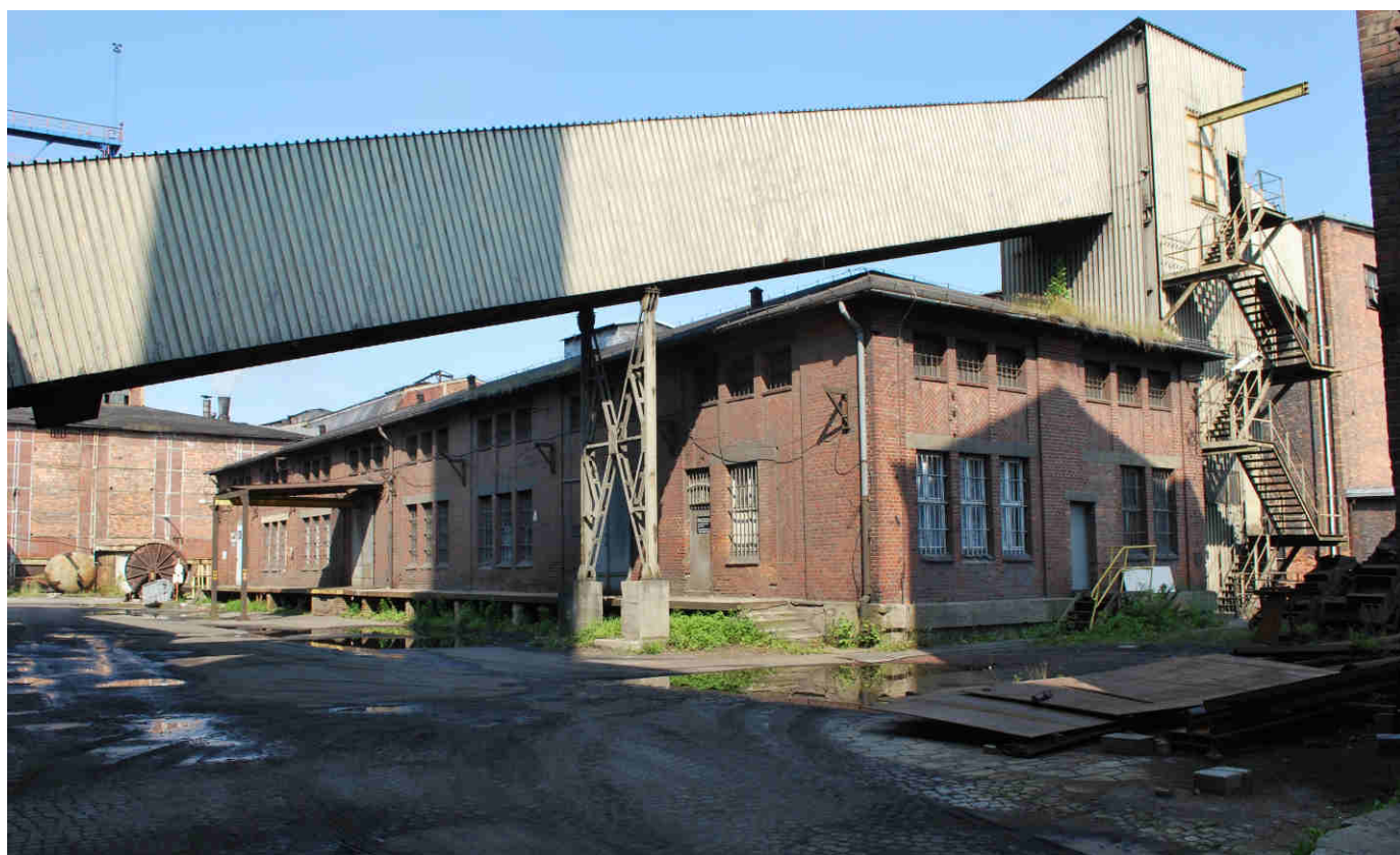
W 1918 roku został wybudowany magazyn główny.
