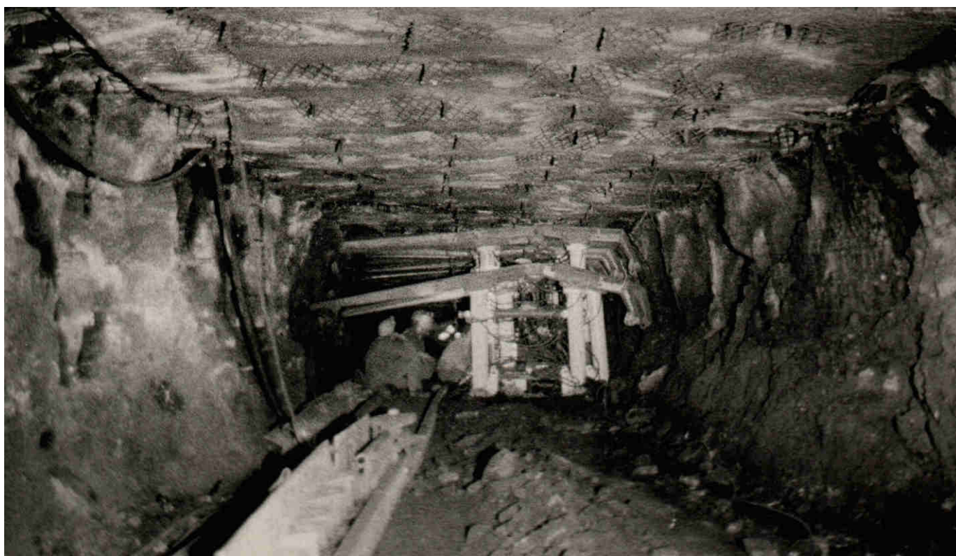
Wprowadzenie obudowy zmechanizowanej do dowierzchni w obudowie kotwicznej.
