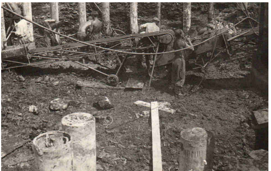
Widoczne „słupy” to rury obsadowe w głowicy mrożeniowej. Szyb głębiany był metodą mrożeniową z powodu występującej kurzawki.
