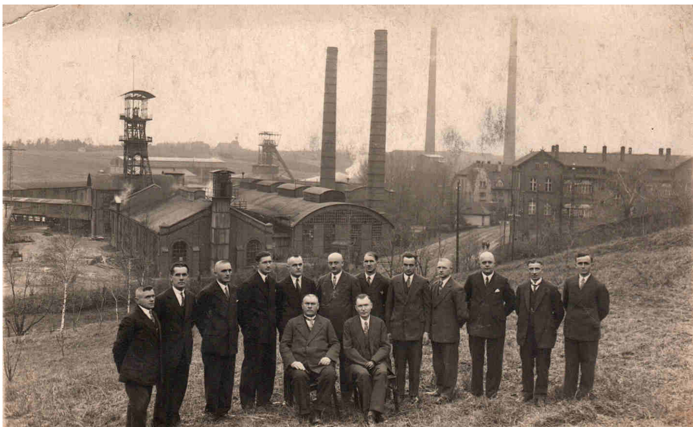
Kierownictwo Elektrociepłowni z 1935 roku.
