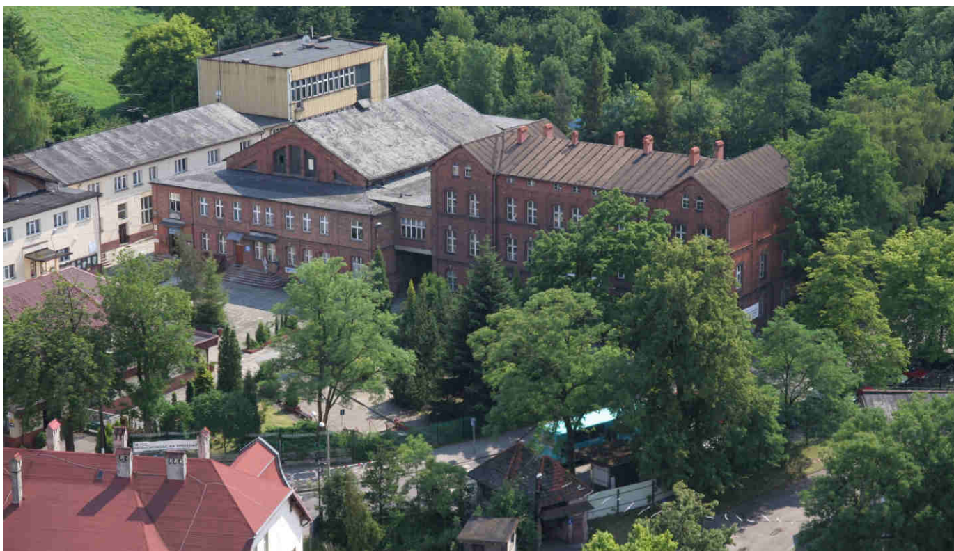
Budynki administracyjne kopalni Anna, stan obecny.
