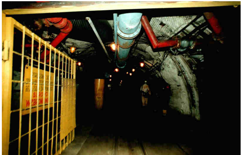
Chodnik główny poziom 1000 m.
