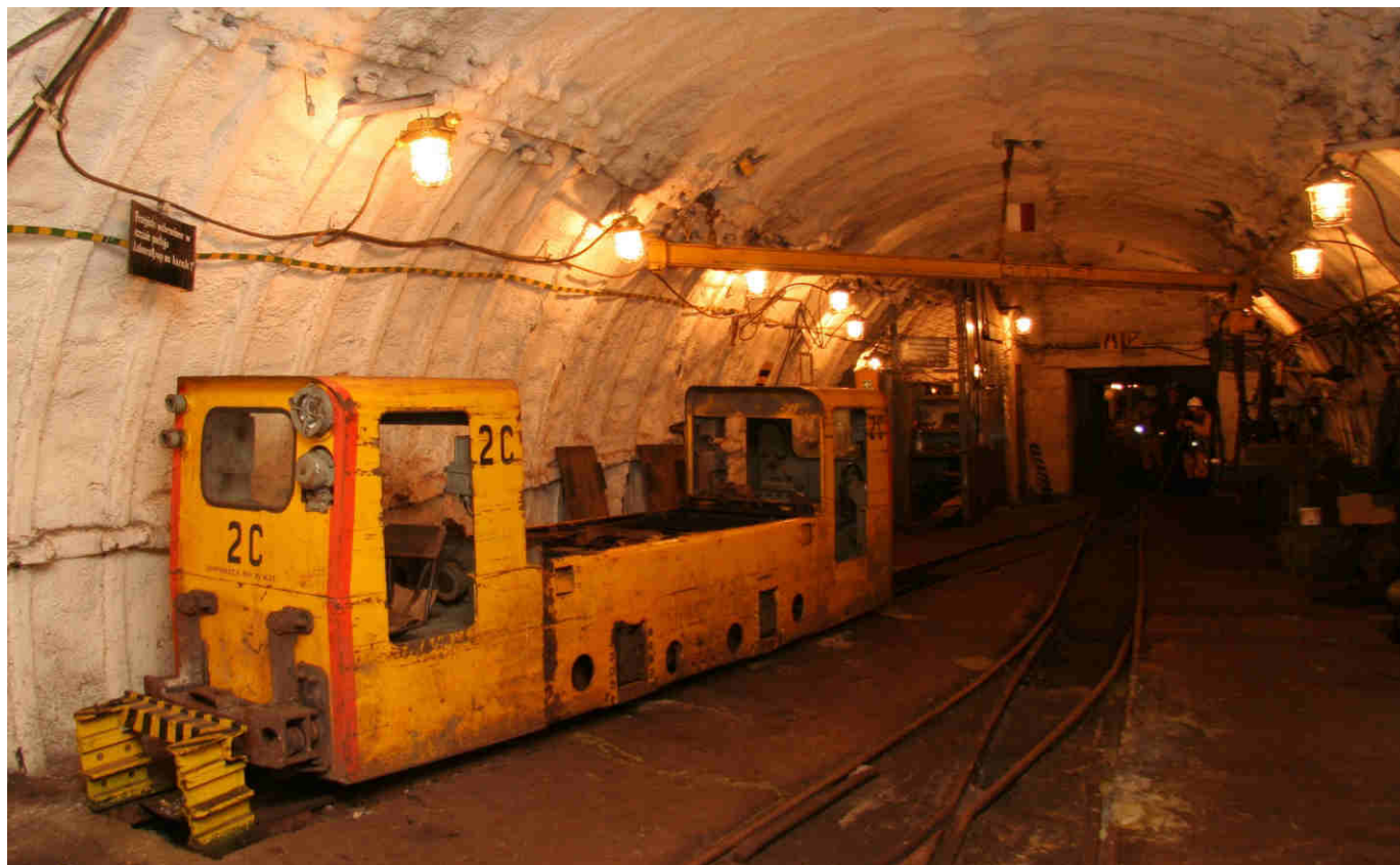
Zajezdnia lokomotyw akumulatorowych, poziom 800 m. Na zdjęciu lokomotywa typu Lea BM 12. W 1967 roku zastosowano po raz pierwszy lokomotywę akumulatorową typu Ldag.
