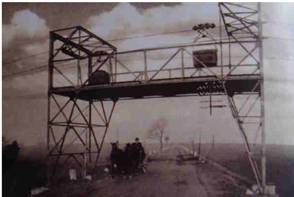
Droga z Pszowa do Rydułtów, a nad nią pomost zabezpieczający przed upadkiem urobku z wagoników kolejki linowej.
