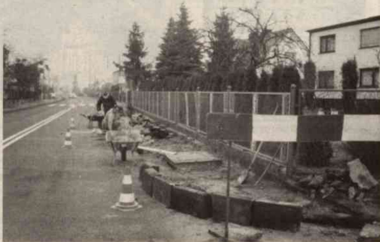
Prace na ulicy Ottona Steiera dobiegły wreszcie końca
