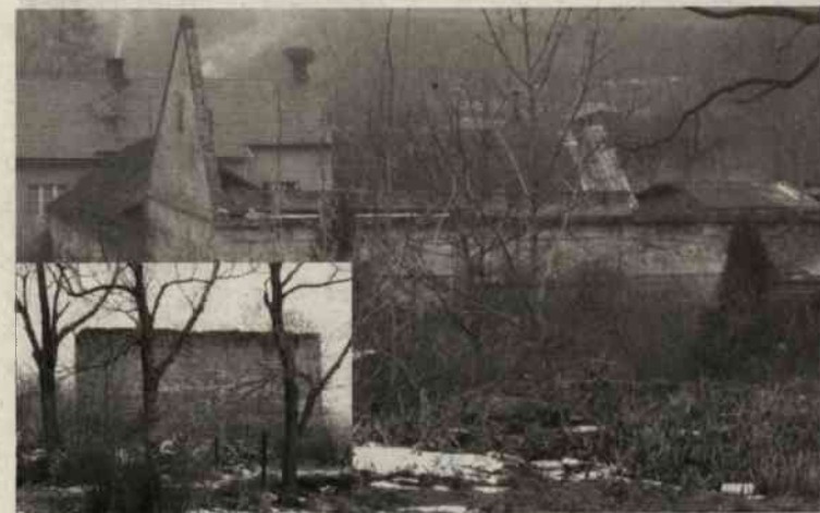
Niektóre budowle w Boguchwałowie grożą zawaleniem
