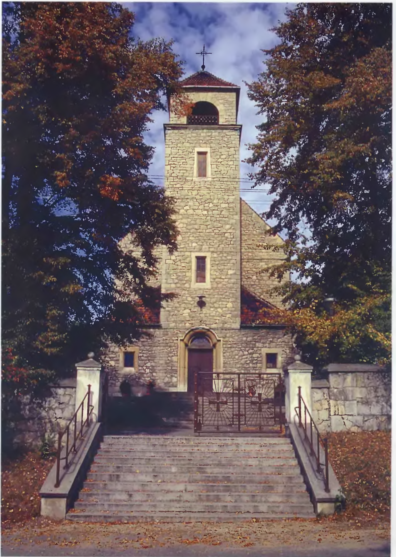
Wyniosła wieża kościoła Najświętszego Serca Pana Jezusa góruje nad Byczyną
