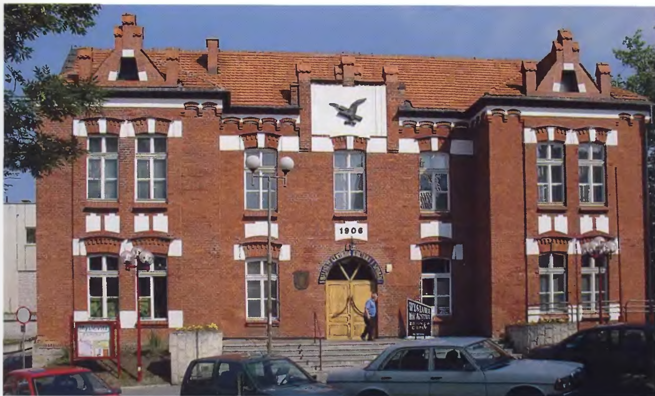
Zabytkowy budynek Towarzystwa Gimnastycznego „Sokół”, wybudowany w 1906 r.
