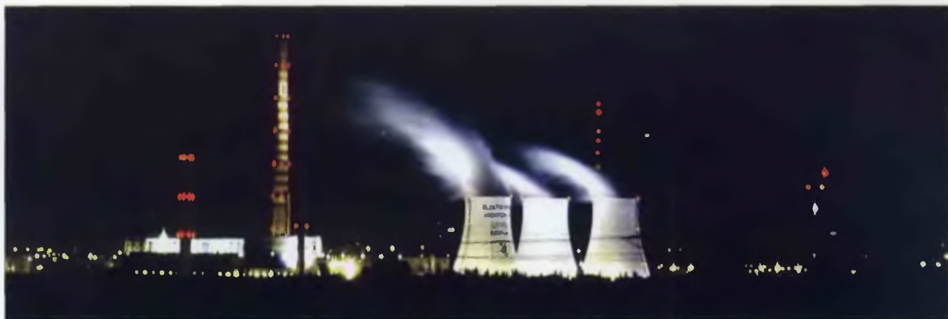
Nocne pióropusze nad Elektrownią Jaworzno III Night warbonnet over the Jaworzno III Power Plant Nächtliches Lichtspiel über dem Kraftwerk „Jaworzno III“
