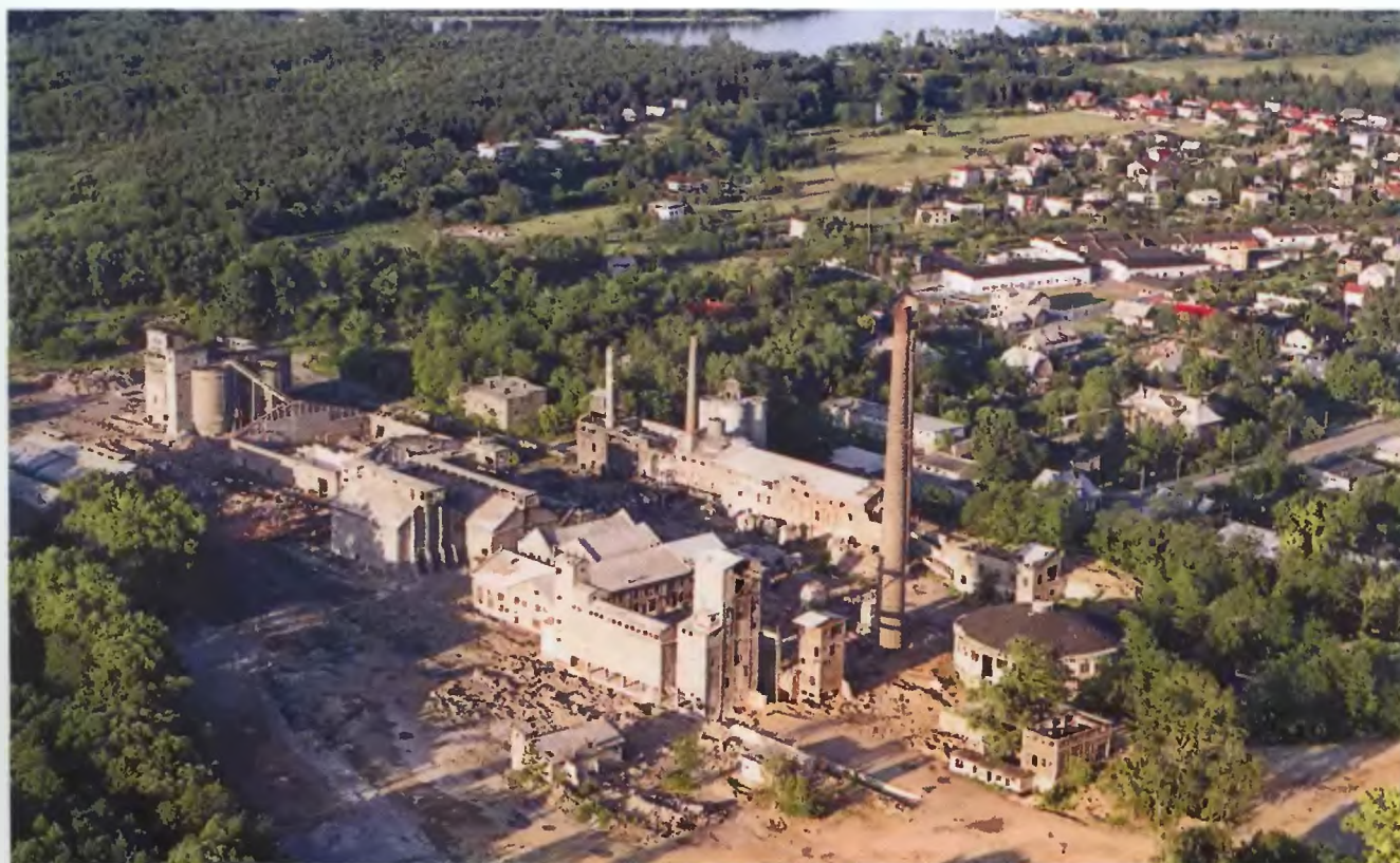
Widok na pozostałości po fabryce cementu portlandzkiego
