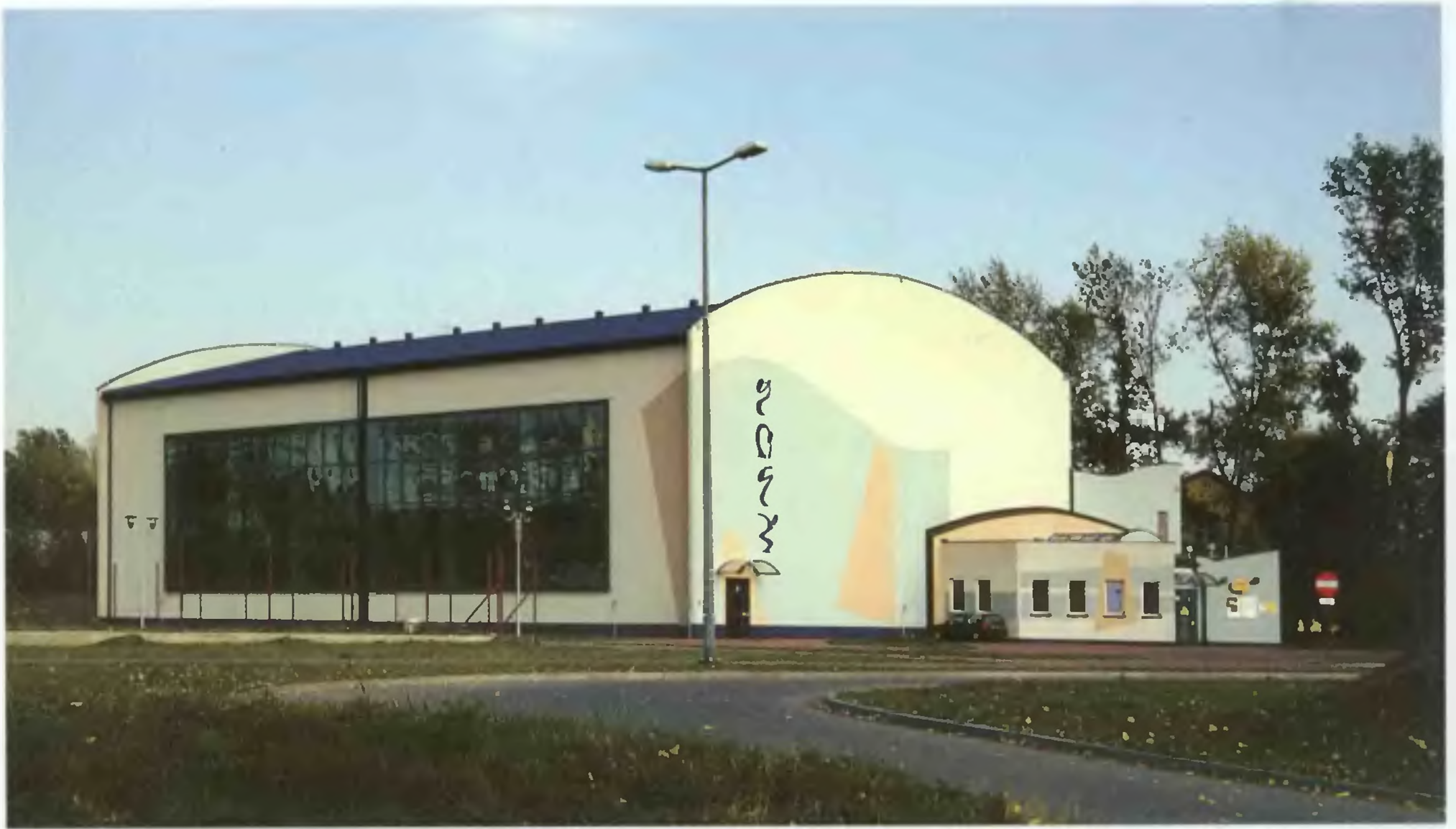
Nowoczesna Hala Sportowa na Osiedlu Stałym
