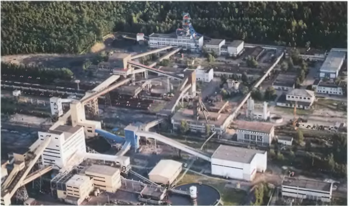
Szyb Sobieski Sobieski shaft Sobieski Schacht
