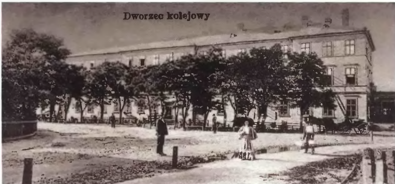
Dworzec kolejowy w Szczakowej
