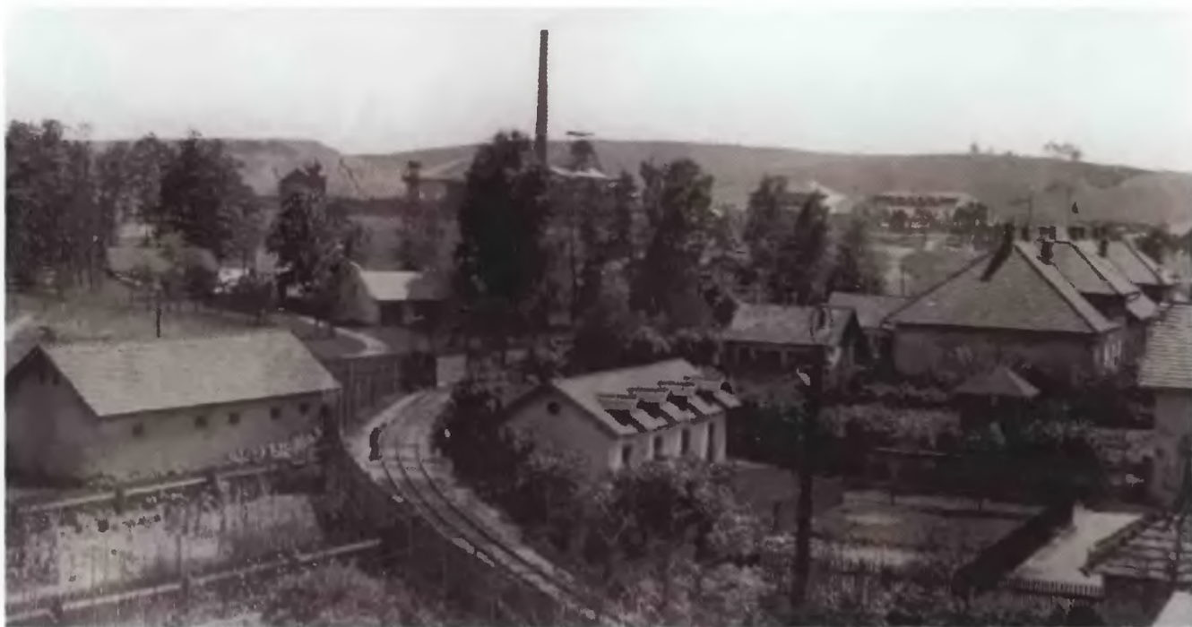
Widok na kolonię robotniczą i szymb Sobieski
