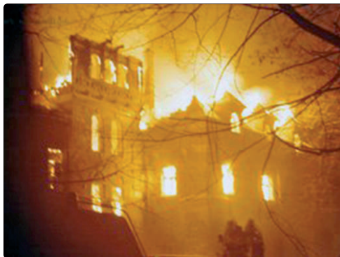
Pożar pałacu fot. Andrzej Głąb
