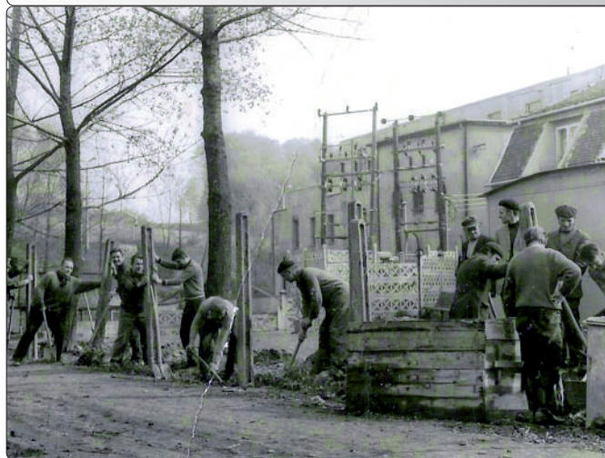
Prace przy ogrodzeniu zakładu fot. Danuta Janosik
