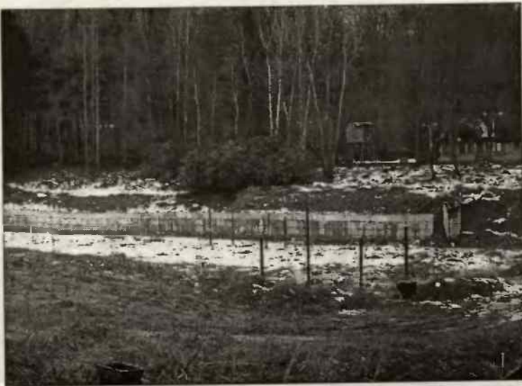
Teren budowy aqua parku
