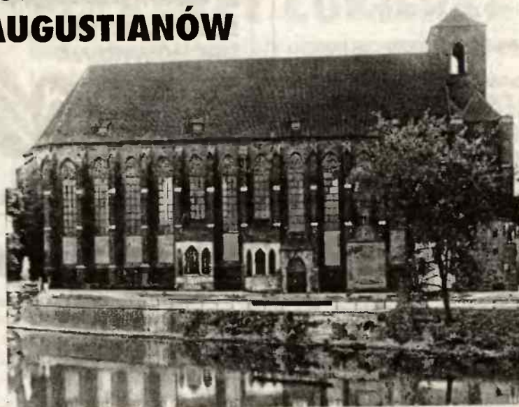
Kościół NPM na Piasku, wybudowany tuż przed przybyciem Jodoka do Wrocławia
