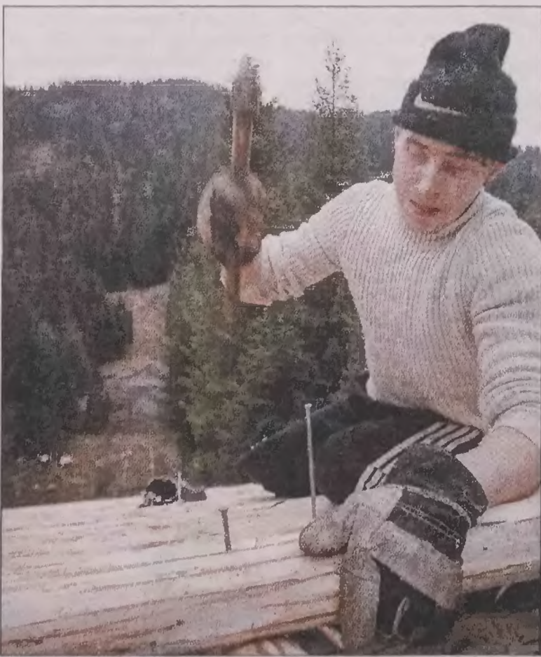
Na skoczni w Wiśle-Łabajowie trwają ostatnie prace modernizacyjne. Jeszcze kilka machnięć młotkiem i obiekt będzie gotowy.
