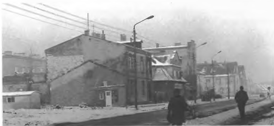
Ulica Szpitalna: dom Głabińskich (wyburzony), Jaworków, drugi dom Jaworków, (wyburzony) domy „Józefowa” i kopalni „Czeladź”
