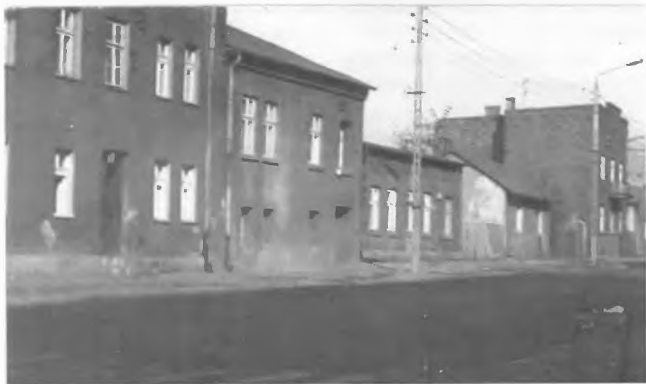
Ulica Szpitalna: wyburzone domy Maćkowskich, Szyjów, Dubielów, Kisielów i istniejący dom Sprzyńskich
