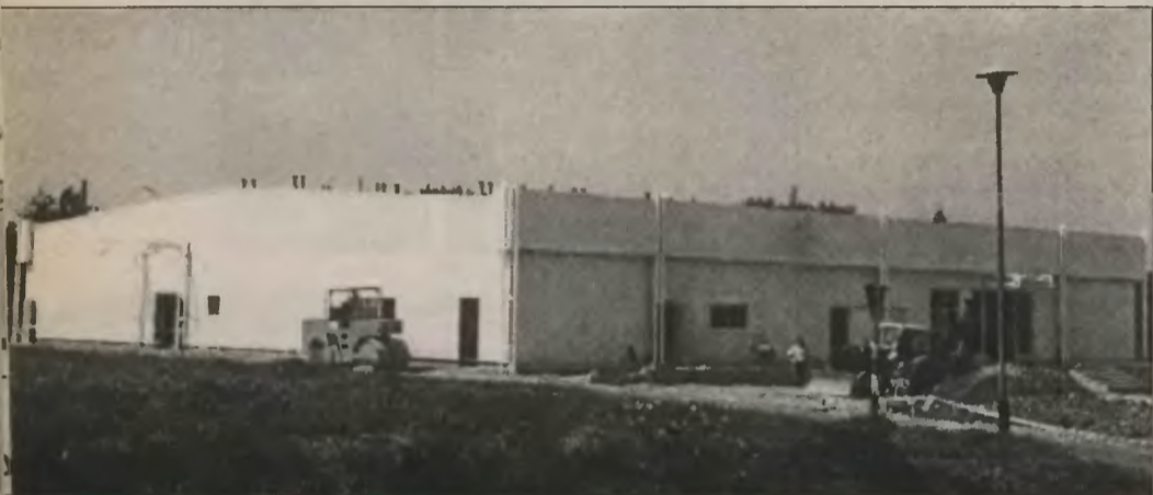
W bliskim tempie budowany jest największy prudnicki sklep u zbiegu ulic Skowrońskiego i Sybiraków. Prace drogowe wokół składowiska (droga, parking) wykonuje ZUK. Prudniczanin podziwiają jak szybko zmienia się na budowie. W chwili publikacji będzie pewnie już nieaktualne zdjęcie.
