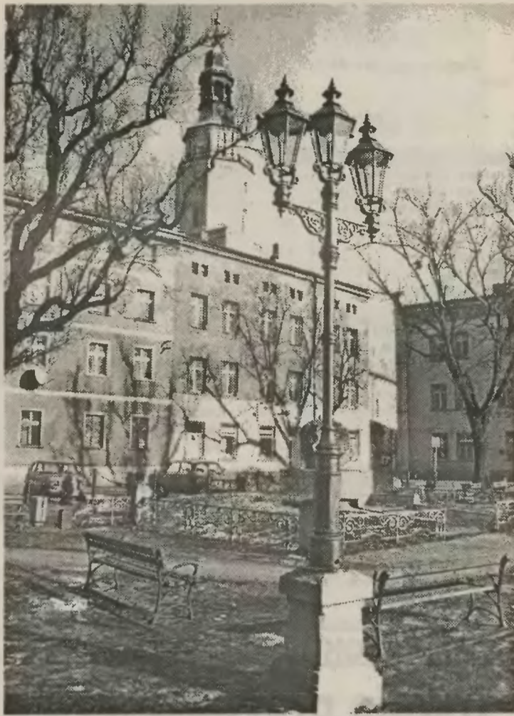
Plac Szarych Szeregów w przebudowie. Nowe lampy są pierwszą oznaką kierunku zmian - na retro. (zdj. W. Steć)
