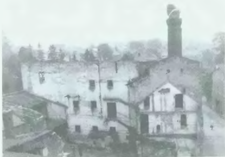
25. Zniszczona słodownia przy ul. Opawskiej w Baborowie
