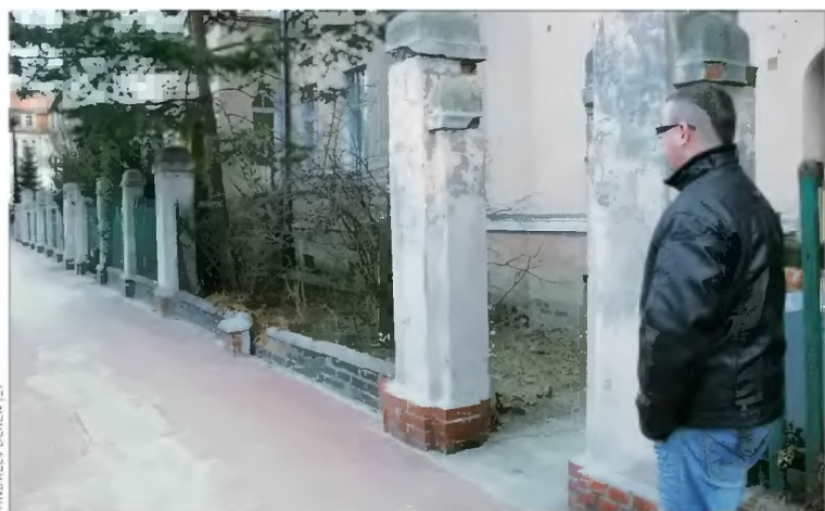
Ogrodzenie przy ul. Dąbrowskiego we fragmentach zostało już rozebrane
