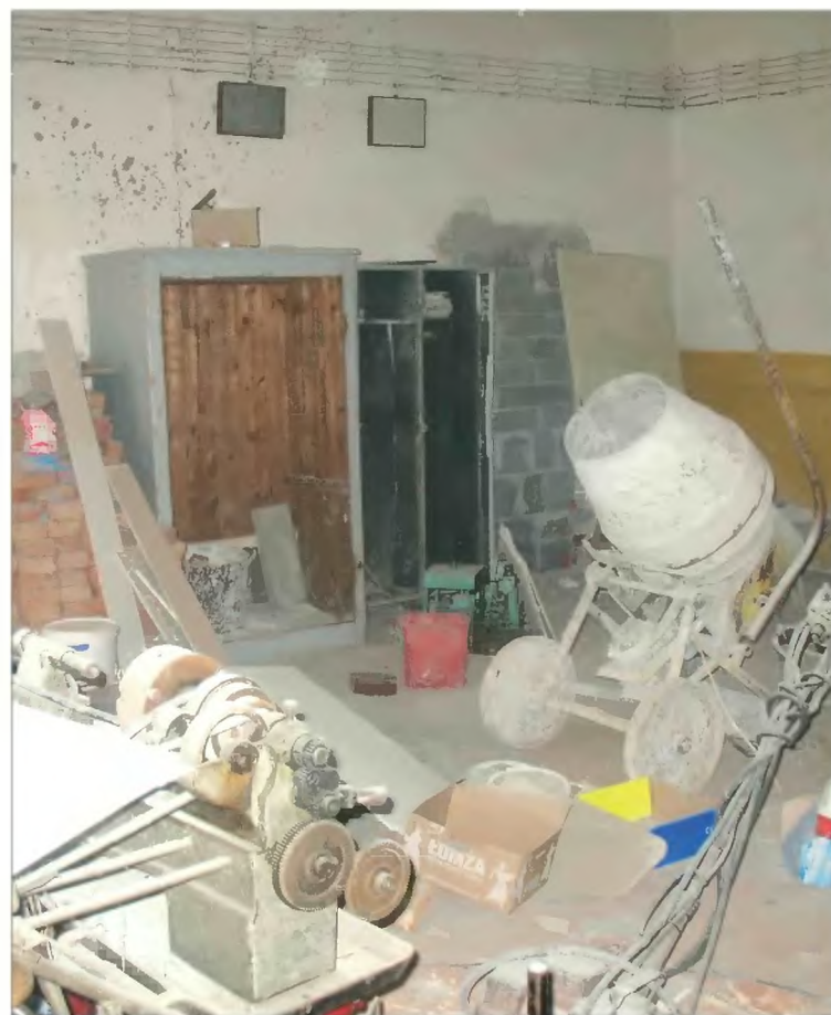
Niewyremontowana (jeszcze) część budynku przeznaczona pod pracownię warsztatową
