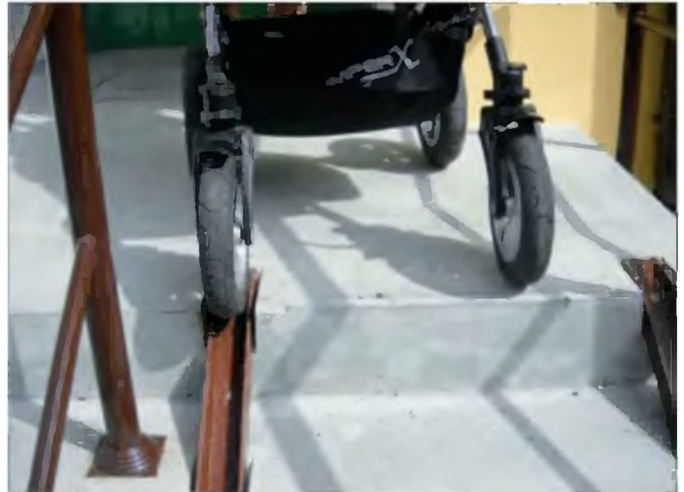
Wąskie szyny nie są dopasowane do wózków dziecięcych, które mają różne rozstawy kół.
