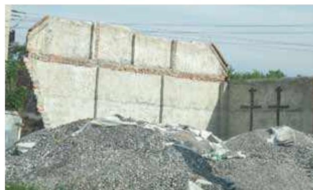
W procedurę usunięcia odpadów włączyła się gmina, ale to osoba, będąca właścicielem terenu, na którym są one składowane pokryje koszty ich wywozu
