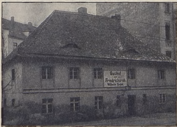
Die alte Friedrichsruh vor dem Abbruch
