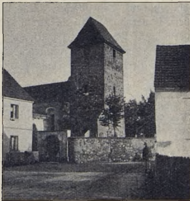
Alte Dorfkirche, Dhas bei Liegnitz Turm und Mauer aus Basalt- und Feldsteinen errichtet (Phot. B. Clemenz)
