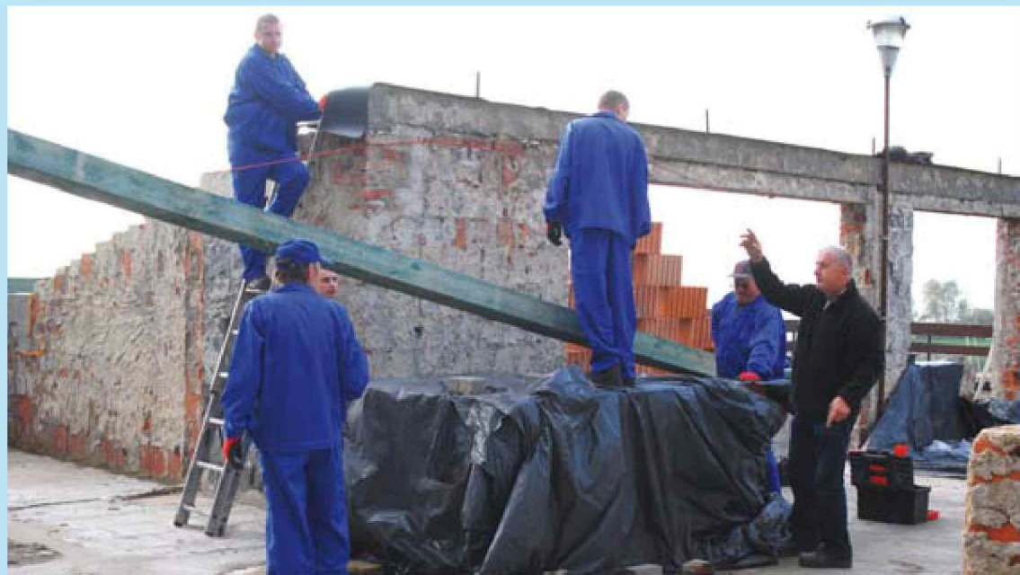
Stancja WOPR zyska dach, a dziesięciu kursantów nowy, poszukiwany zawód cieśli budowlanego. Pierwszy z prawej instruktor Marek Twardowski.
