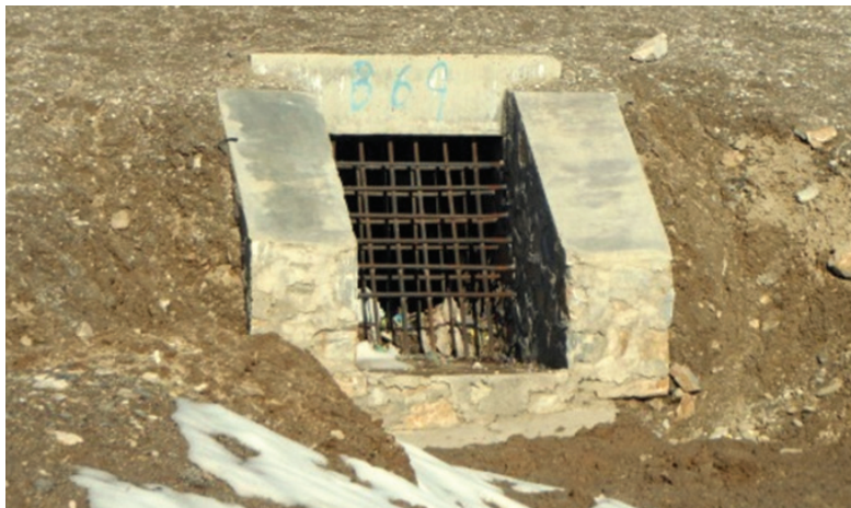
Fot. 2. Zabezpieczenie przepustu kratami i czujnikami przed umieszczeniem wewnątrz miny pułapki Źródło: archiwum własne autorów
