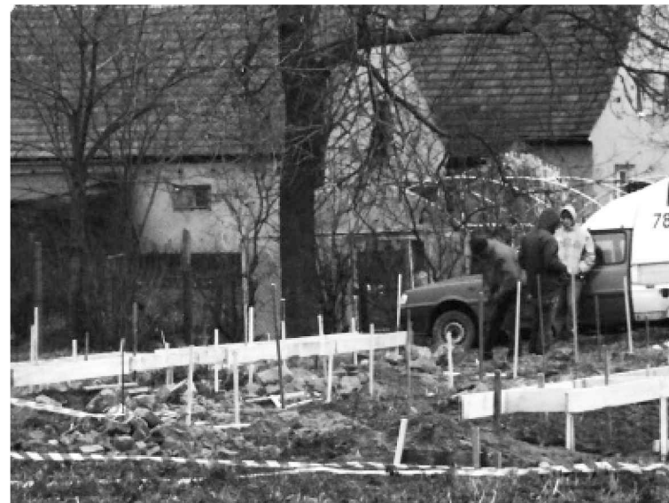
Nowe fundamenty pod starą świetlicę
