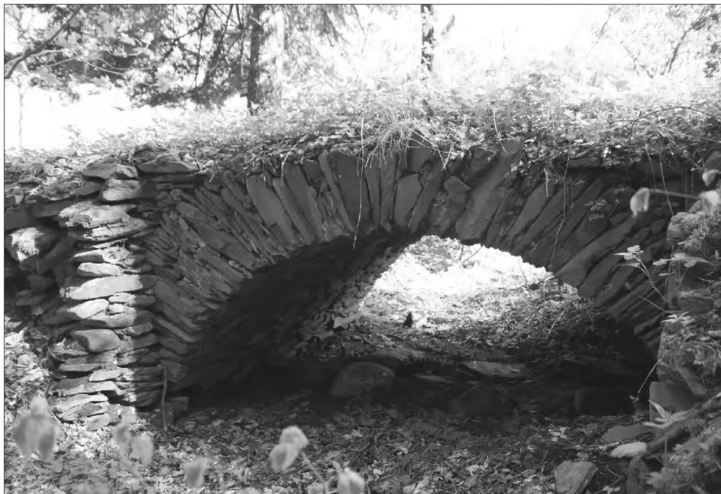
Kiedyś w tym miejscu płynęła woda
