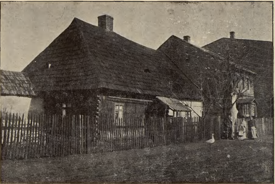
Das erste Schulhaus, 1830—60. Nach einer Aufnahme v. J. 1902.
