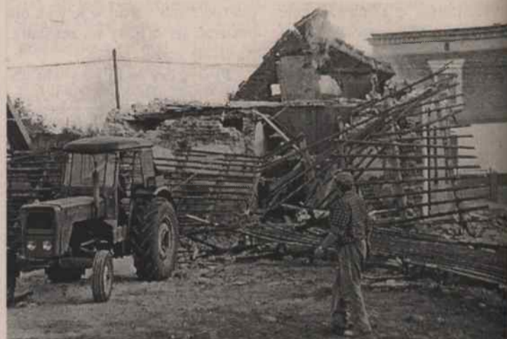
Kolejne etapy likwidacji rudery przy ul. Gliwickiej w Brzeźcach.
