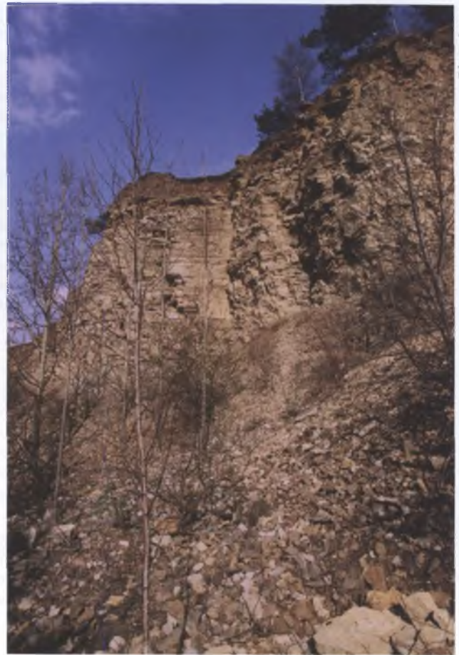
Kamieniołom Sodowa Góra, widoczne osypiska
