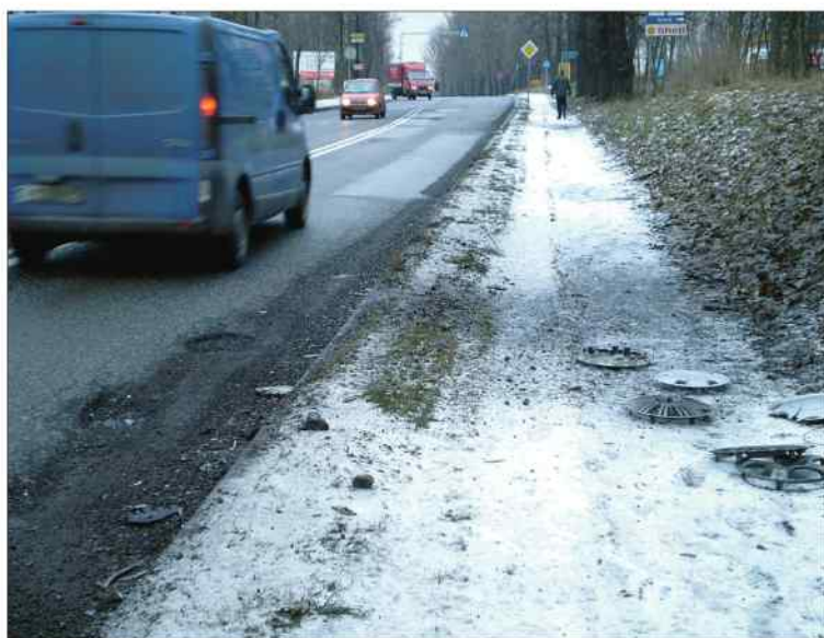
Na poboczu ul. Katowickiej naliczyliśmy kilkanaście kołpaków
