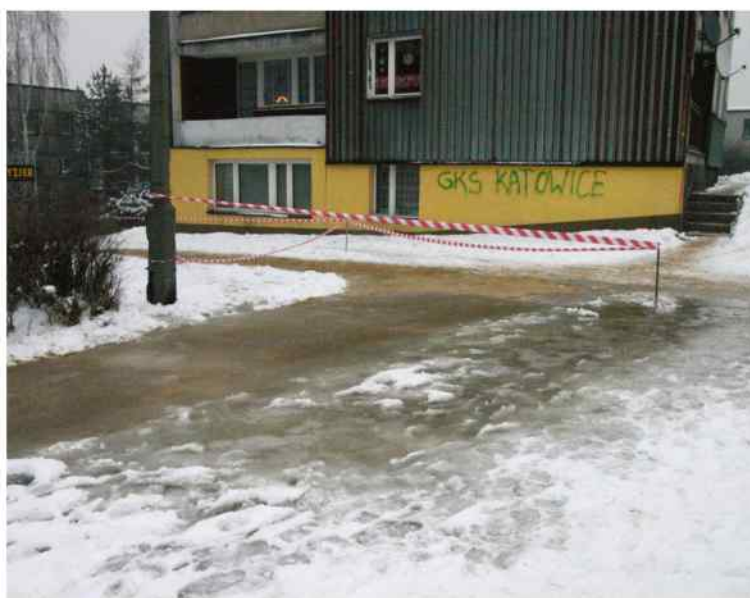
Z powodu wycieku chodnik zamienił się w ślizgawkę
