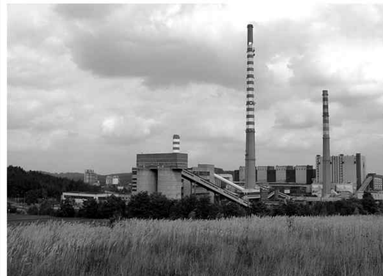
Elektrownia Siersza II
