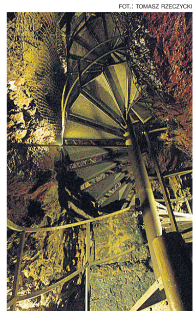
Klatka schodowa w szybie łączącym dolną i górną sztolnię.
