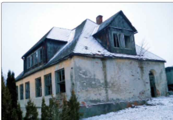
Budynek dawnej szkoły
