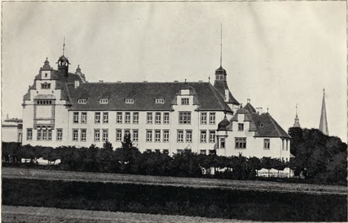
Westseite des neuen Gymnasialgebäudes
