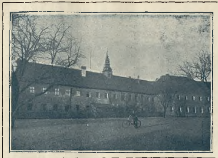
Südseite des alten Gymnasialgebäudes.
