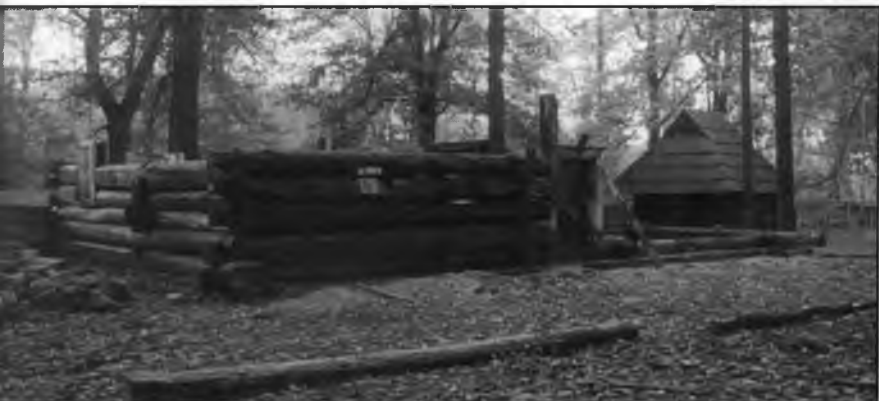
„Zagroda Wsi Pszczyńskiej” w 1974 roku - montaż chałupy z Grzawy po konserwacji środkami chemicznymi.
