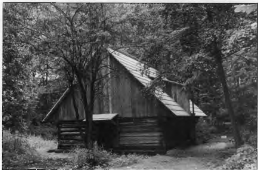
Wozownia po zakończeniu odbudowy dachu.
