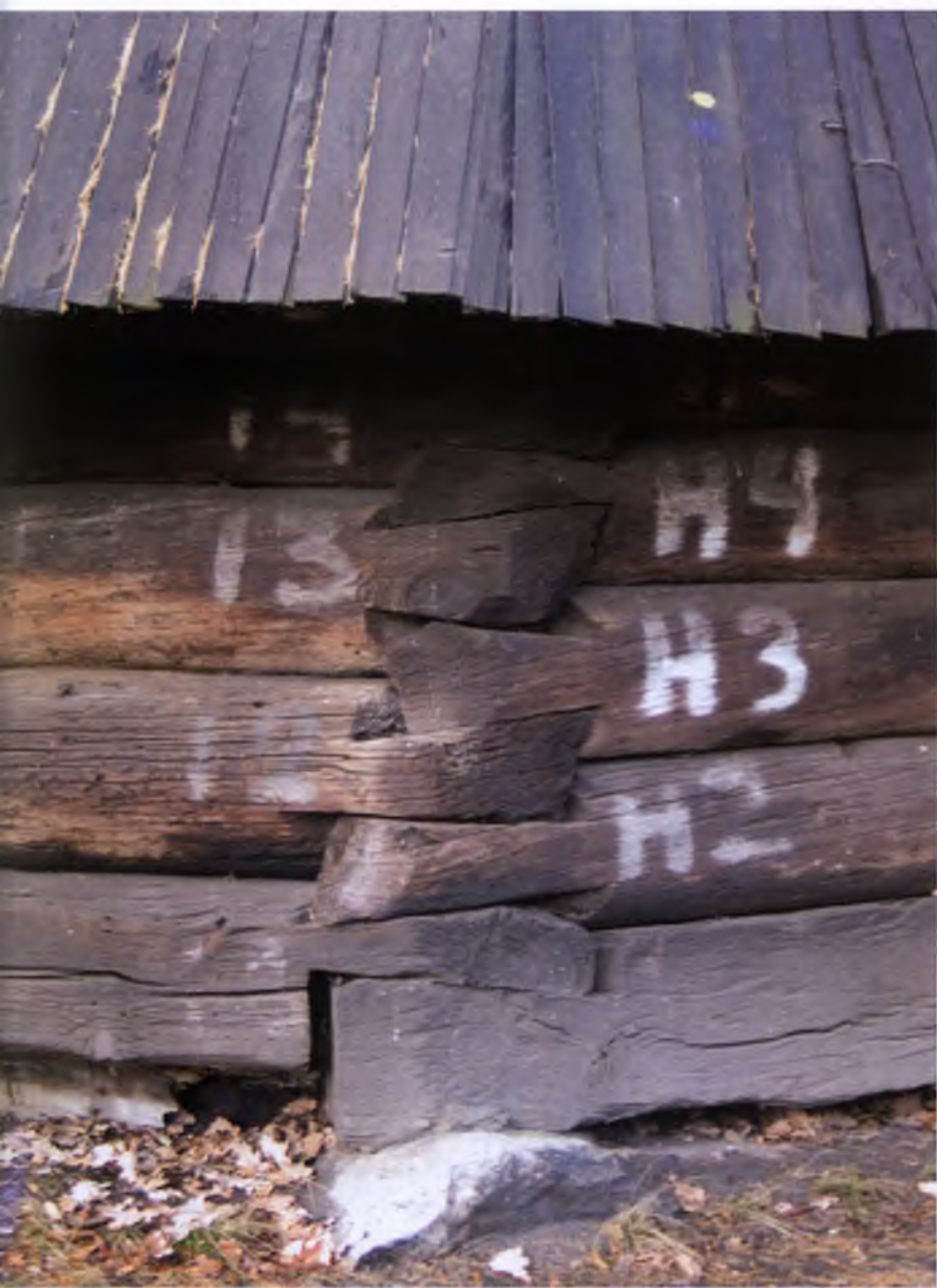
Zrąb stodoły ośmiobocznej z Kryr. Łączenie półplazów na jaskółczy ogon.
