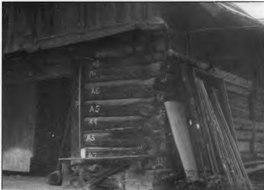
Fragment wozowni w Warszowicach (in situ).
