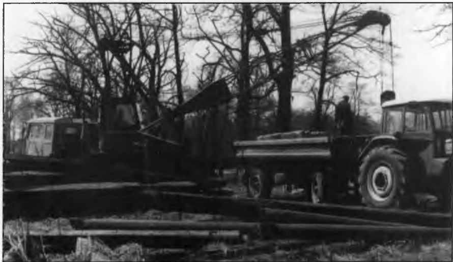
Do montażu piętrowego spichlerza z Czechowic potrzebny był dźwig. Jak oni to kiedyś stawiali tylko siłą ludzkich mięśni?
