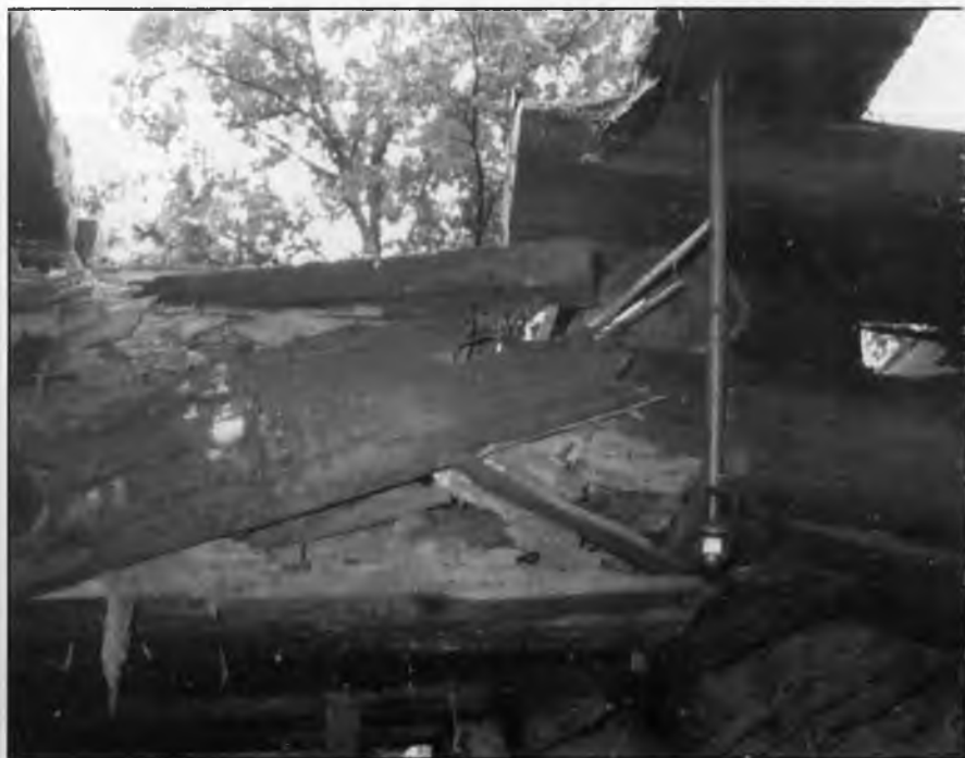
Efekt niszczącej siły mokrego śniegu - zawalona konstrukcja dachu spichlerza.
