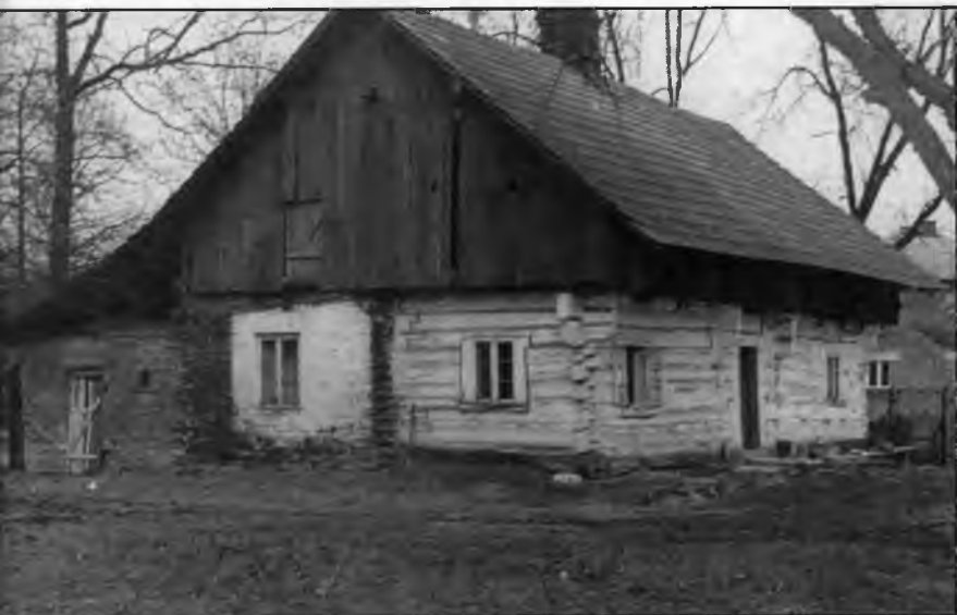
Chałupa Czmajducha z 1831 roku w Grzawie. Zniszczona część budynku została dobudowana z cegły. Na zdjęciu widać późniejsze podniesienie dachu, tzw. wyżkę.
