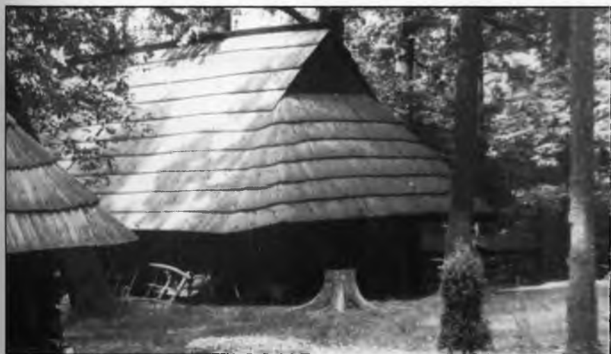
Masztalnia z Wielkiej Wisły po zmontowaniu w skansenie.
