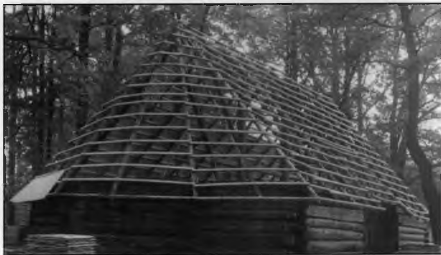
Stodoła 8-boczna z Kryr - łączenie więźby dachowej w skansenie.
