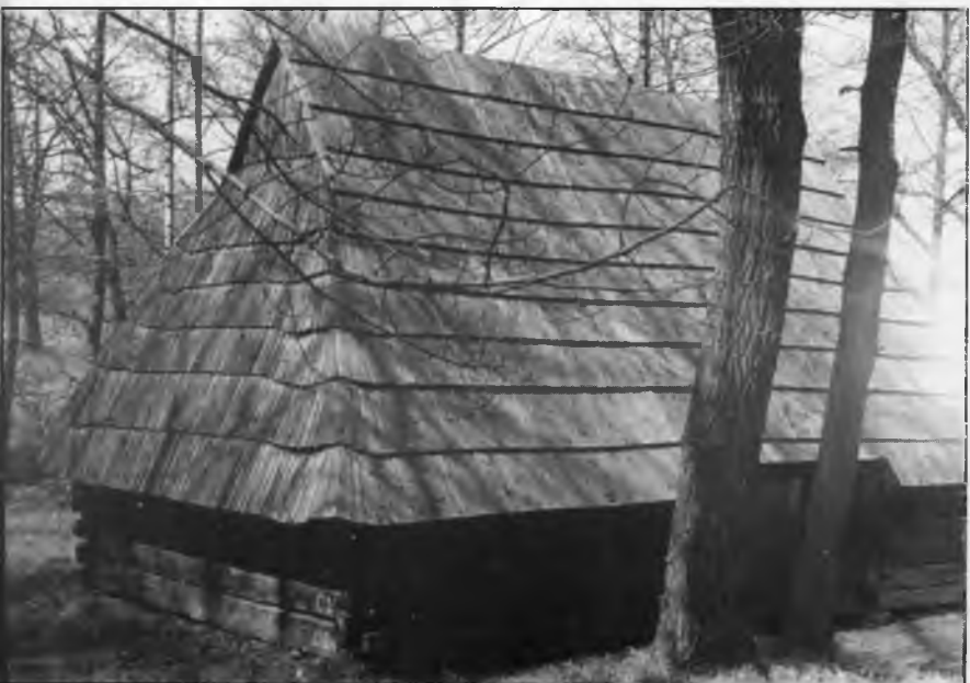
Stodoła z Kobielic po przeniesieniu do skansenu i pokryciu gontami.
