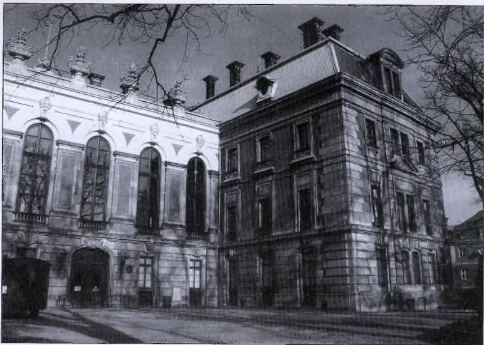
Pałac Książąt Pszczyńskich – skrzydło wschodnie od strony starówki. Fot. A. Spyra
