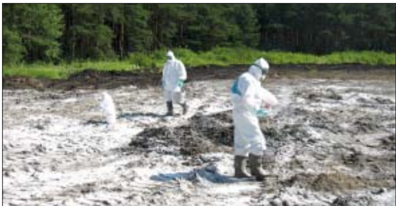
Pracownicy dąbrowskich wodociągów usuwają szkodliwy osad.
