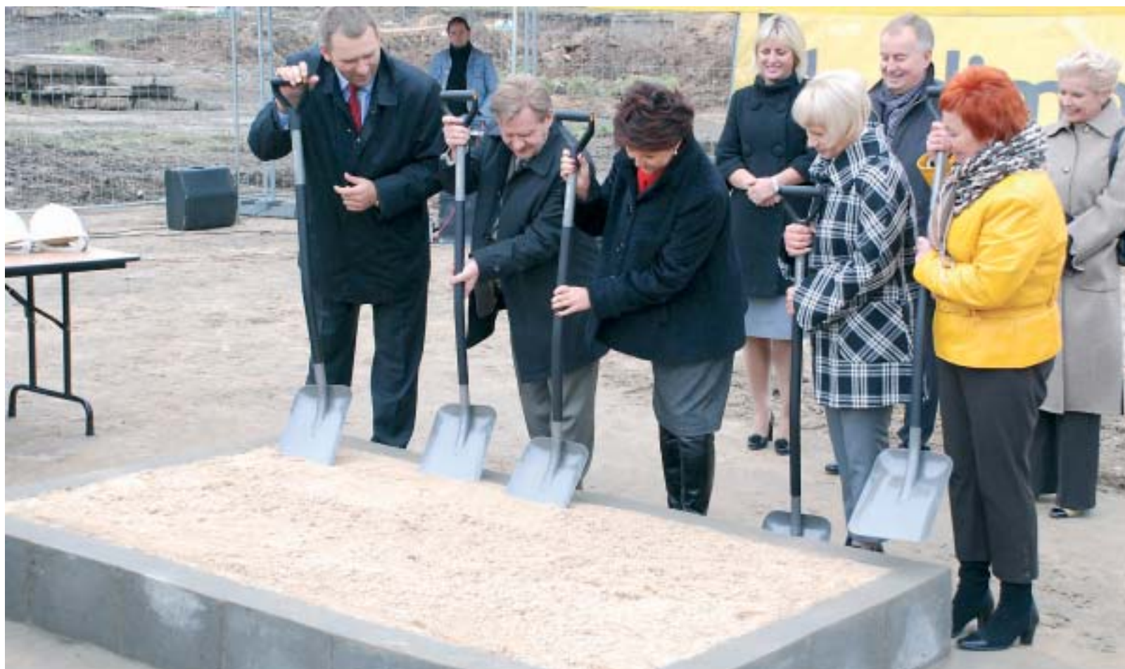
Symboliczne wbicie łopat na budowie ośrodka dla niepełnosprawnych.
