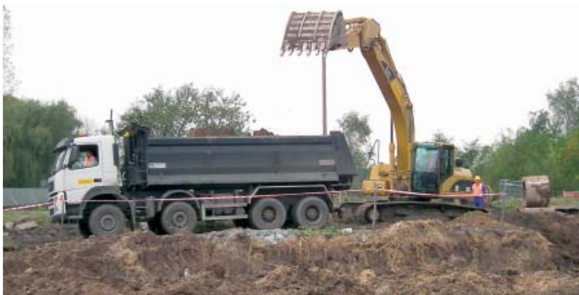
Firma Budimex pełną parą rozpoczęła inwestycję.
