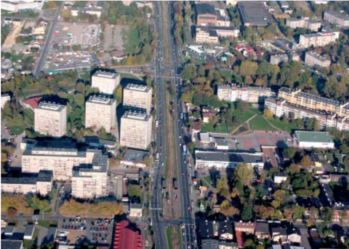
Wyremontowana zostanie nawierzchnia jezdni i chodników ul. Królowej Jadwigi na odcinku od skrzyżowania z al. Róż do skrzyżowania z ul. Wojska Polskiego.
