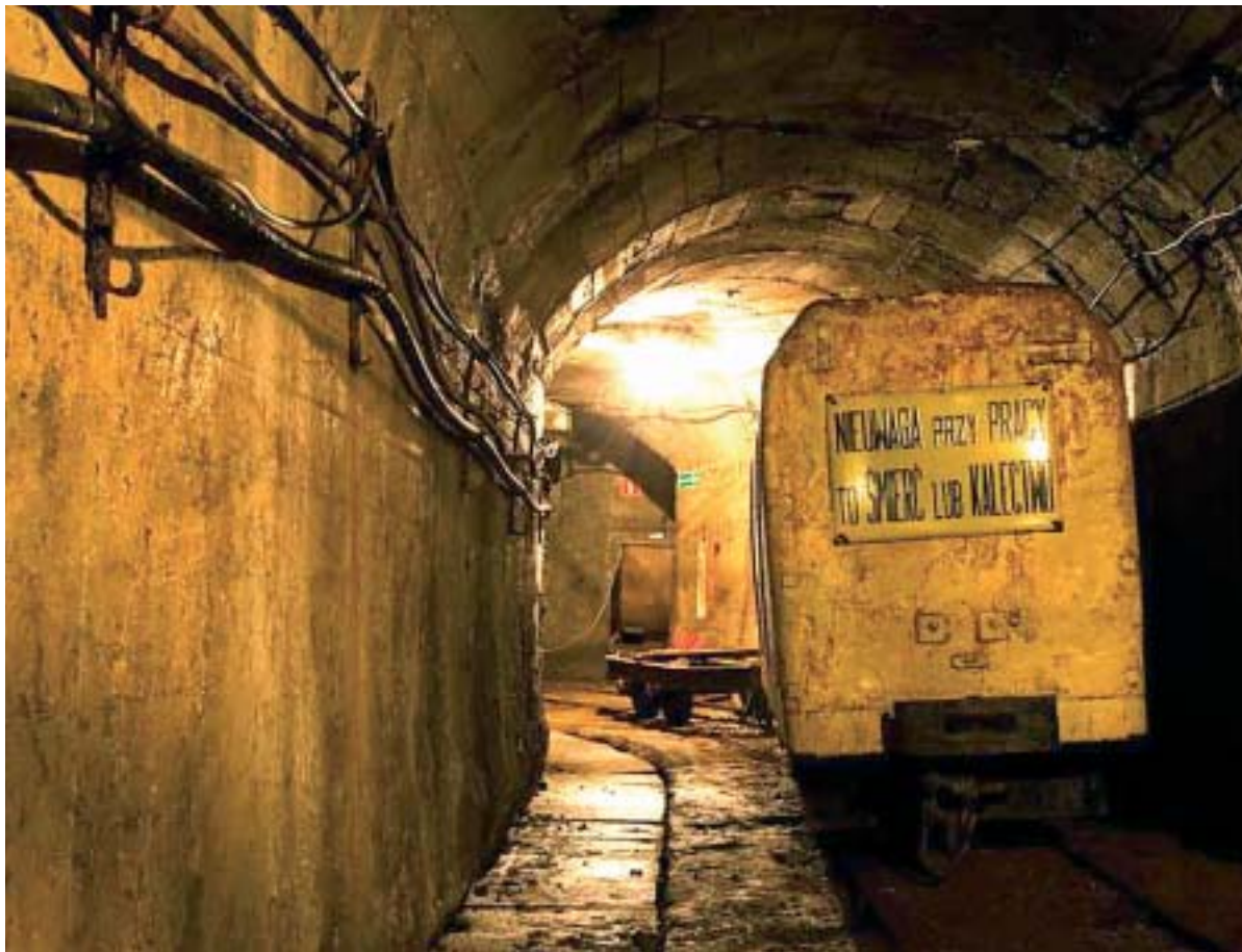
Podziemia Kopalni Ćwiczebnej kryją wiele tajemnic.
