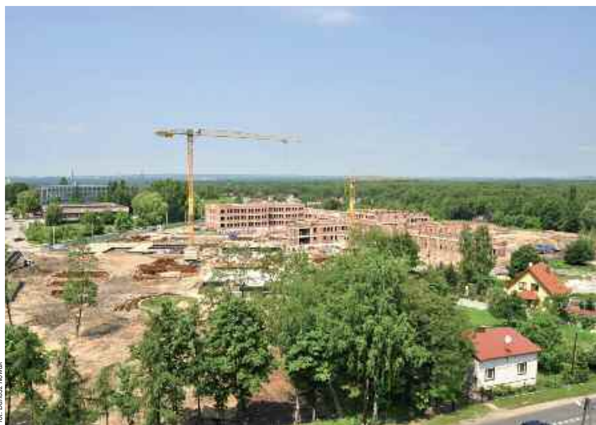
Ośrodek Szkolno-Wychowawczy budowany jest pomiędzy ulicami Gwardii Ludowej i Sadową.
