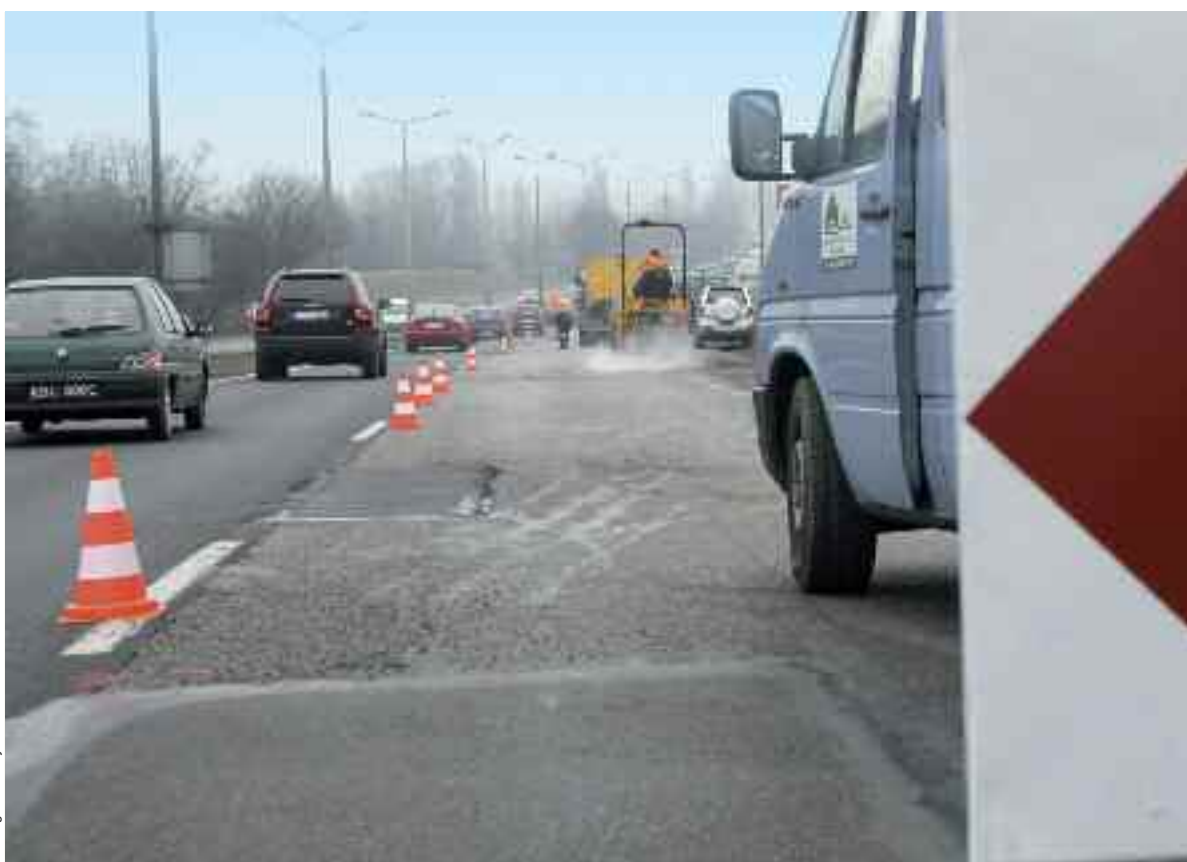
Drogowcy wykorzystują sprzyjającą pogodę na naprawę nawierzchni.
