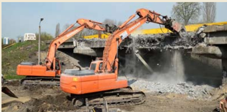
Generalny remont DK 94 jest jedną z kluczowych inwestycji miejskich
