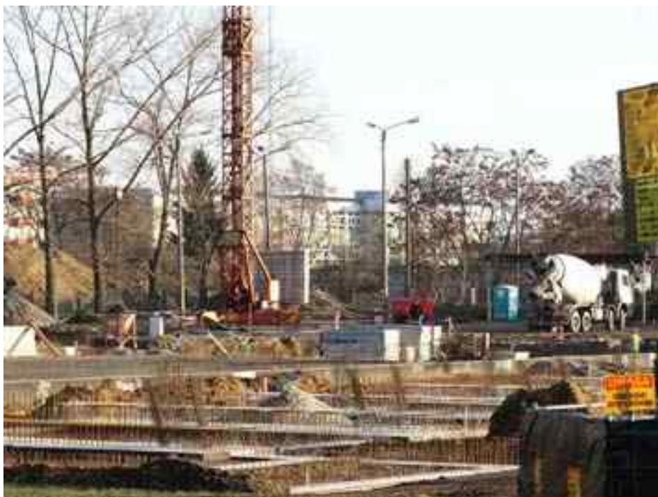
Pogoda sprzyja, a więc prace przy budowie nyskiej hali trwają
