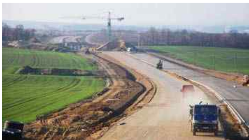
Pomiędzy budowanymi wiaduktami i mostami, miejscami widać już w znacznym stopniu wykonaną szeroką dwupasmówkę.
