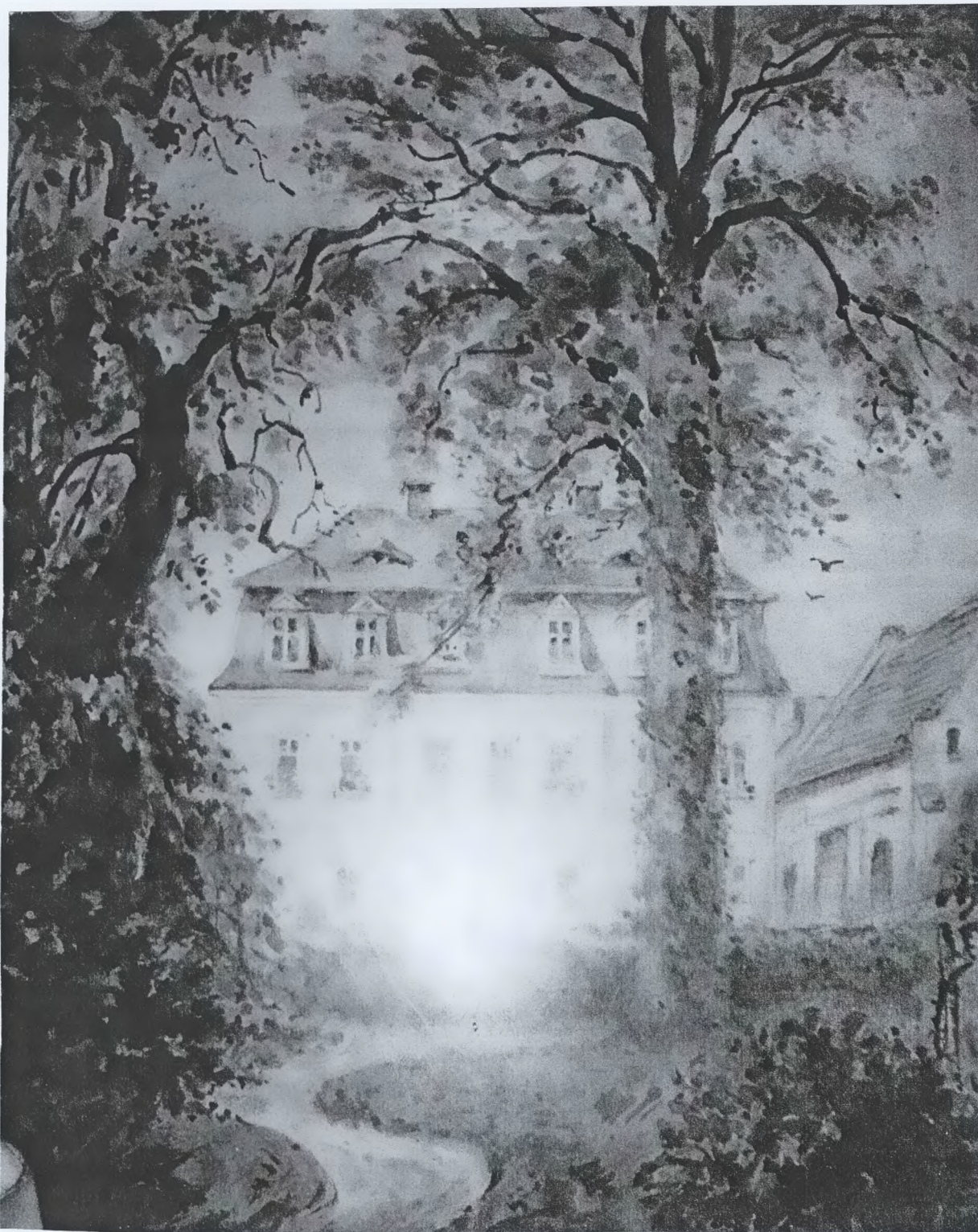
OBRAZ NIEZNANEGO MALARZA - PAŁACYK WŁASCICIELA POSIADŁOŚCI - DABROWA - USZKODZONEGO W CZASIE DZIAŁAŃ WOJENNYCH. POZOSTAŁOŚĆ ROZEBRANO W LATACH 70 - 80 - LATACH.
