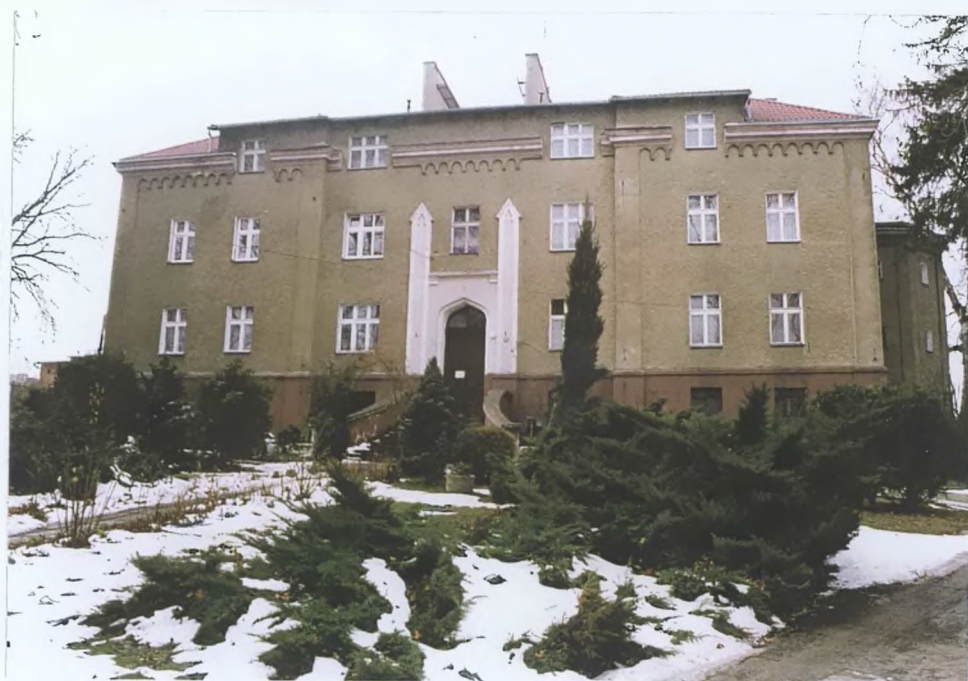
BUDYNEK W CZASIE DZISIEJSZYM
