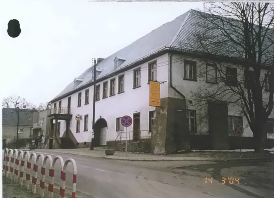
PO ROKU 1945 GOSPODA, MIESZKANIA PRYWATNE ORAZ SIEDZIBA GMINNEJ SPÓLDZIELNI. OBECNIE WŁASNOŚĆ PRYWATNA.
