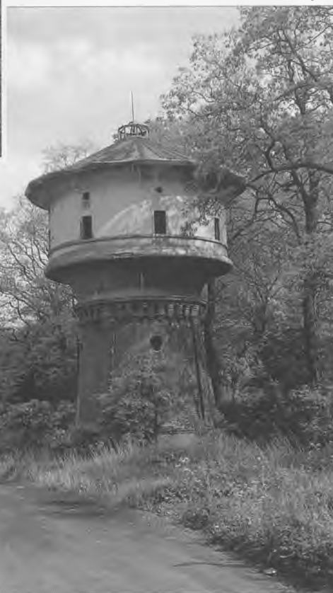
Zabytkowa wieża wodna niechybnie skazana na likwidację. 07.08.2004 r. fot. Robert Ślęzak
