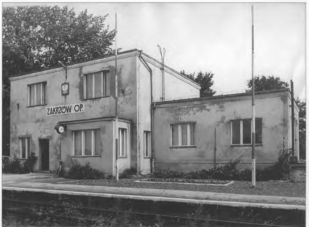
W roku 1975 budynek dworca w Zakrzowie już nie prezentował się tak dostojnie jak w dniu otwarcia.
