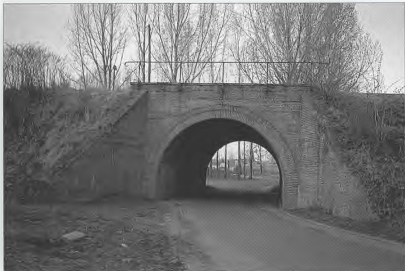
Na tym sklepionym, ceglany mście w Głubczycach biegną dwa tory: zasadniczy z Baborowa i nieczynny już tor boczny własności Zakładów Piwowarskich. 31.03.2002 r.
