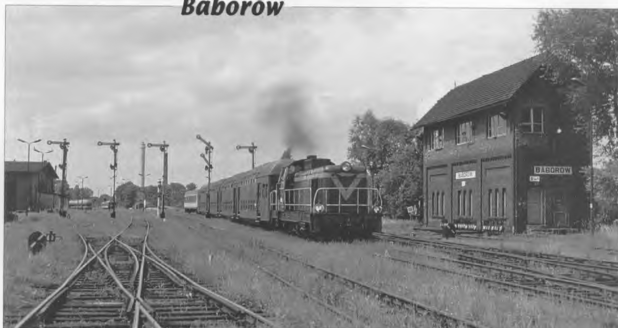
SP42-100 do Raciborza opuszcza stację Baborów na tle nastawni wykonawczej Bw1. Zwraca uwagę doczepiony na końcu składu wagon klasy 1. 25.07.1998 r. fot. Andrzej Cichowicz
