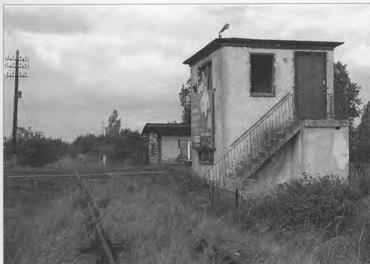
Posterunek przejazdowy w km 1,5 w Kędzierzynie Koźlu przy ruchliwej drodze krajowej nr 40 (na mapie z drugiej strony okładki - nr 408) z Pyskowic przez Kędzierzyn Koźle, Głogówek, Prudnik do Głuchozą. U dyżurnego znajdował się dziennik ruchu z ostatnim zapisem w dniu 7 lipca 1997 roku. 12.09.2003 r. fot. Robert Ślęzak
