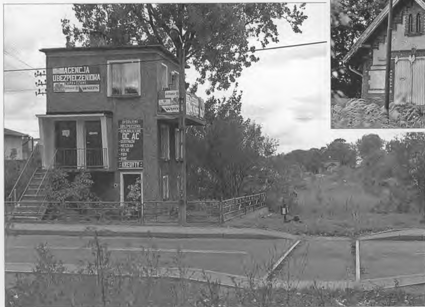
Stacja Reńska Wieś. Budynek dawnego posterunku przejazdowego nr 9 na drodze z Kędzierzyna Koźla przez Pawłowiczki do Głubczyc (na mapie z drugiej strony okładki - nr 418). Widoczne po prawej szyny skutecznie zaasfaltowano w 2004 roku. W głębi widoczny budynek dworca. 12.09.2003 r.
