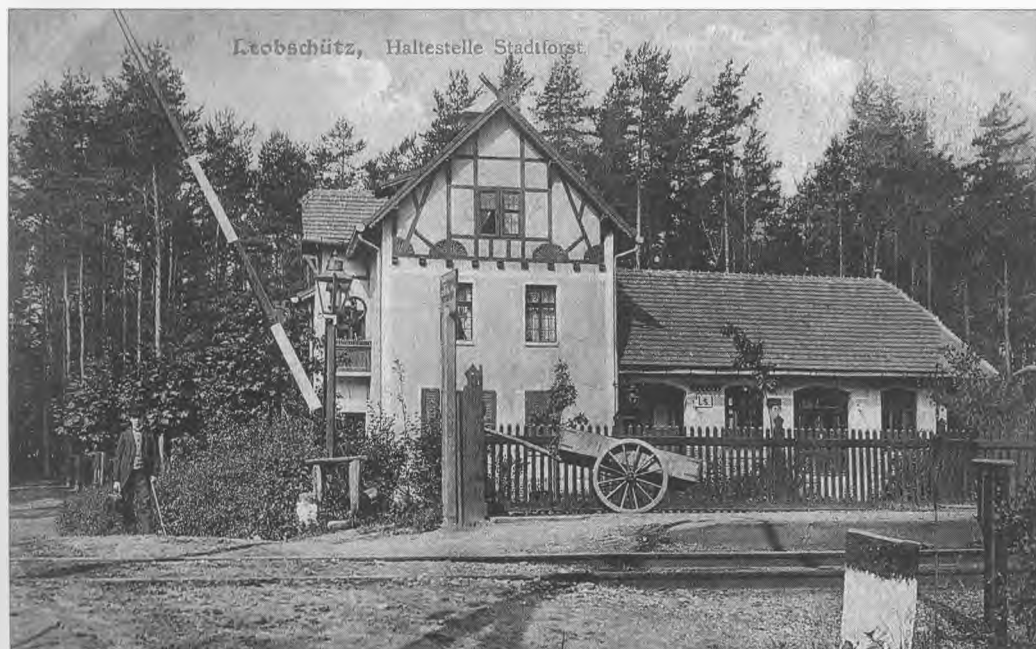
Budynek kolejowy na przystanku Głubczyce Las z około 1909 roku.
