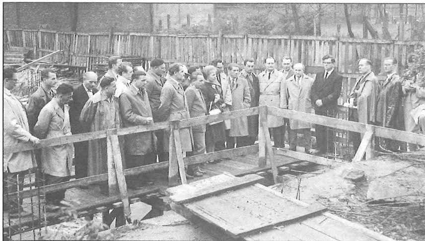
Maj 1962 r. - uroczyste wmurowanie aktu erekcyjnego pod budowę gmachu nowej drukarni gazetowej.
