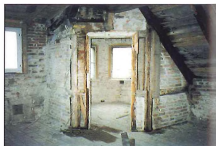
Wnętrze w trakcie remontu
