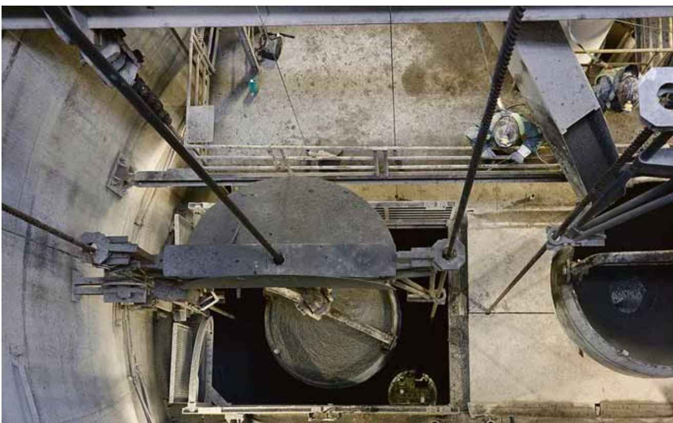
Jeden z siedmiotonowych kubłów wypełniony betonem zjeżdża na dół.
