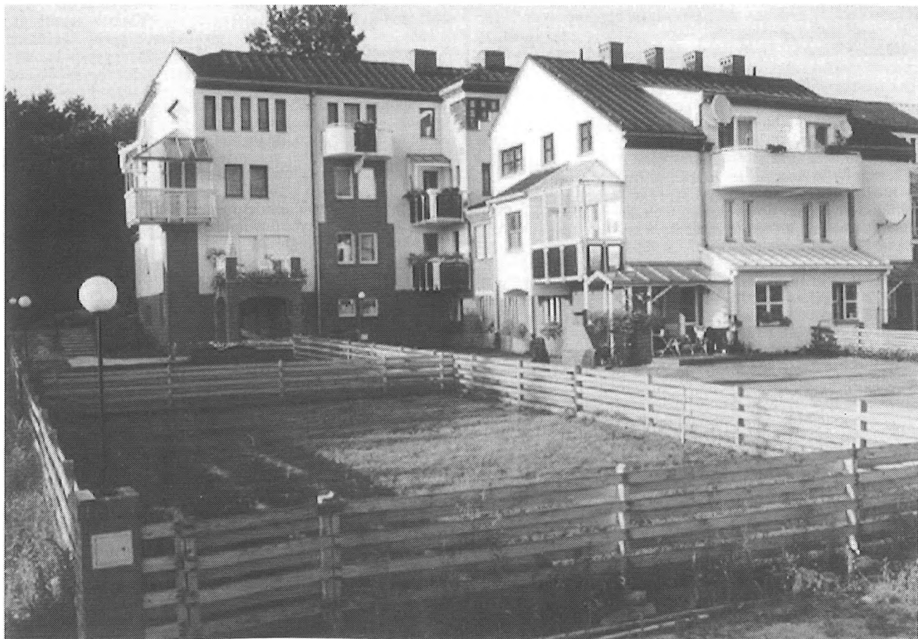
Katowice-Panewniki. Zespół Mieszkaniowy, ul. Uroczna. Biuro autorskie: „AiR Jurkowski architekci”; autorzy: arch. Ryszard Jurkowski, współpraca arch. Anna Jurkowska, inwestor: Sp-nia „Sadyba”.
