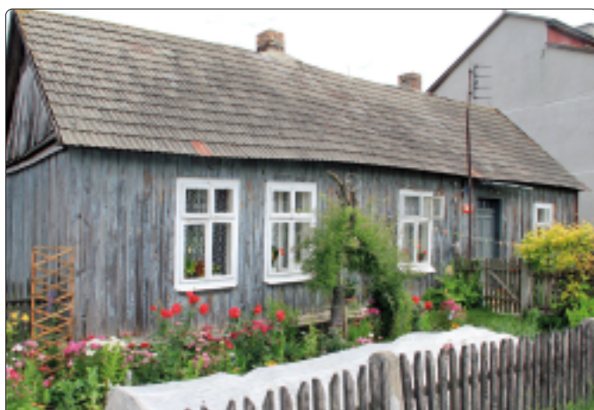
Budynek mieszkalny zabytkowej zagrody okołowej
